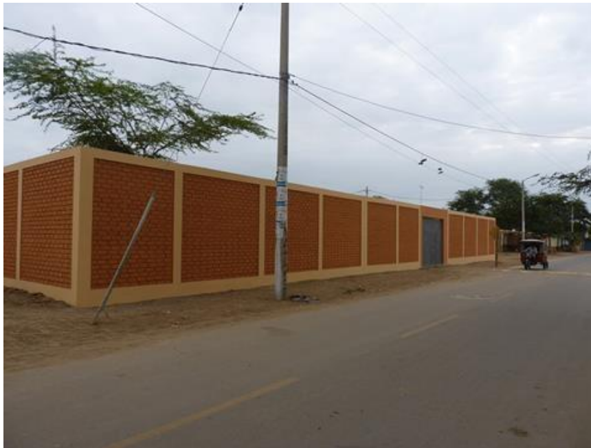
Figura 11. Vista panorámica de un cerco perimétrico de albañilería confinada. Nota. Fuente: Contreras, O. (2016).
