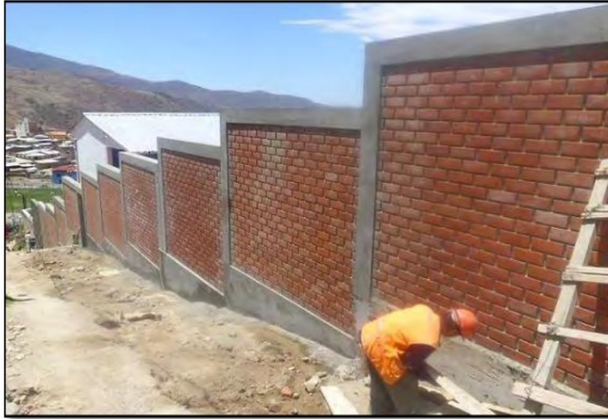
Figura 10. Elementos de cierre de cerco perimétrico aplicado mediante sistema confinado. Nota. Fuente: Vivar, M. (2015).
