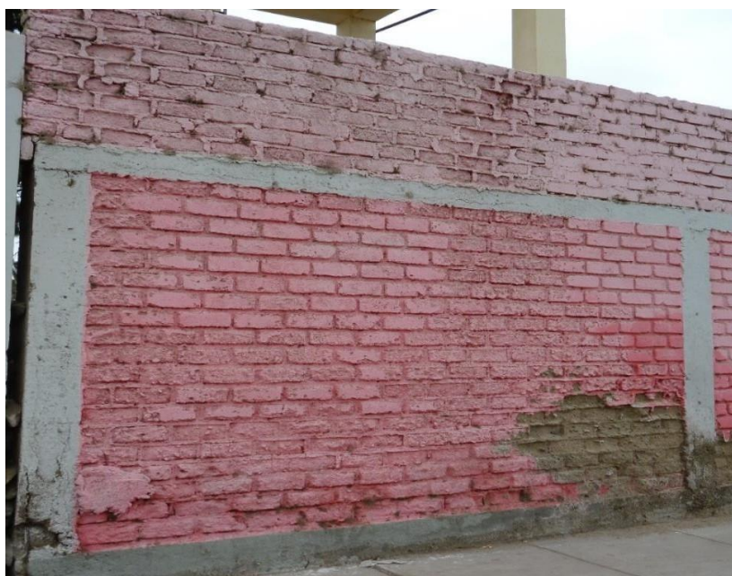
Figura 1. Muro de albañilería confinada afectada parcialmente en la parte inferior y en la superior a consecuencia de los agentes atmosféricos.
