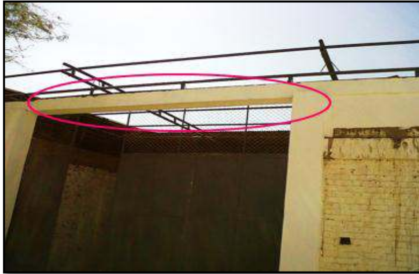
Grafico 05: Viga de concreto armado
