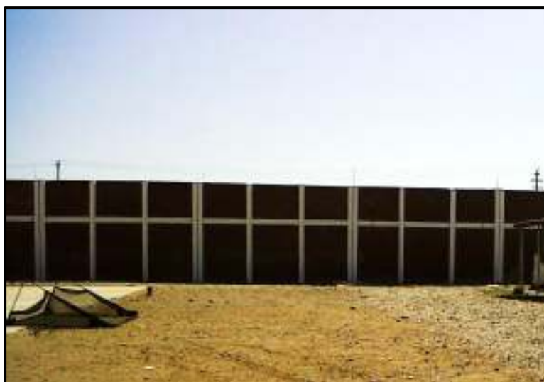
Grafico 02. Albañilería confinada en cerco perimétrico
