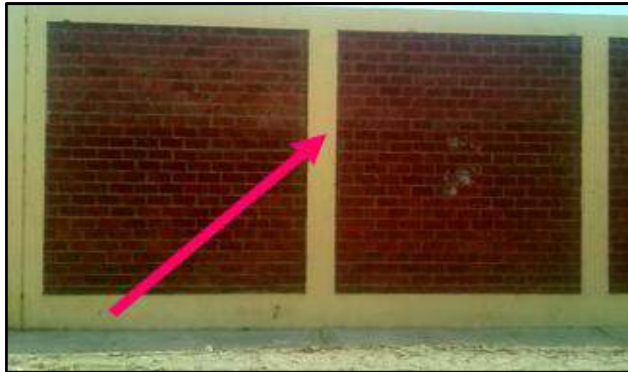
Grafico 04: Columna de concreto armado
