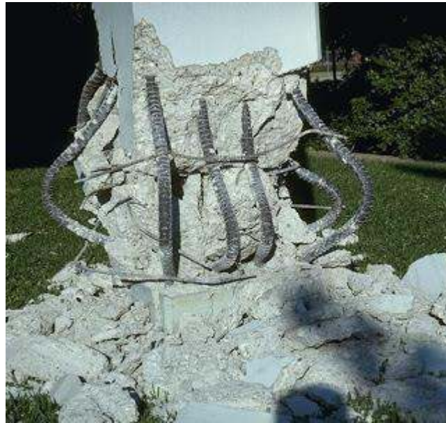
Gráfico 16: Pandeo – Fuente: Construyafacil
