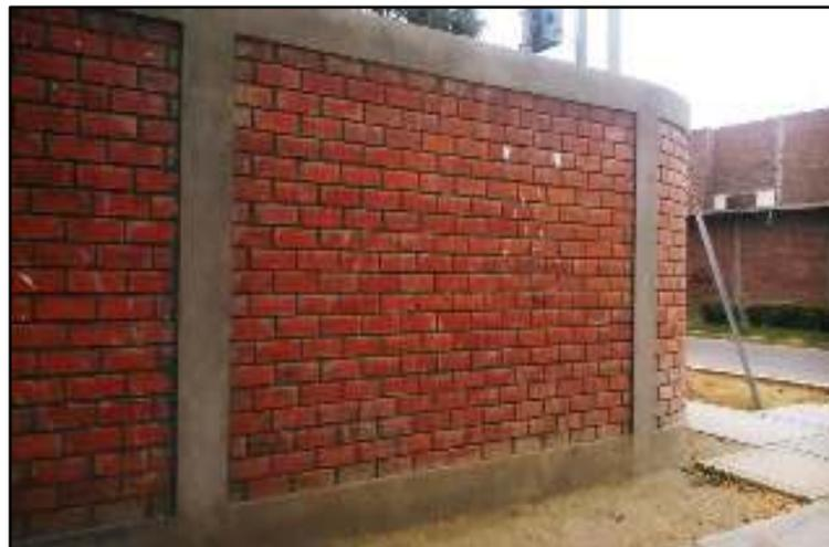
**Grafico 03. Estructura de albañilería confinada**
