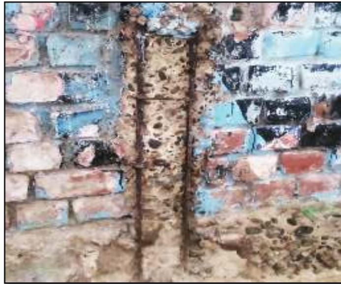
**Grafico 15. Corrosión del acero en estructuras de concreto armado.**
