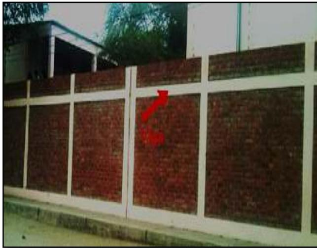
**Grafico 06. Viga de albañilería confinada**
