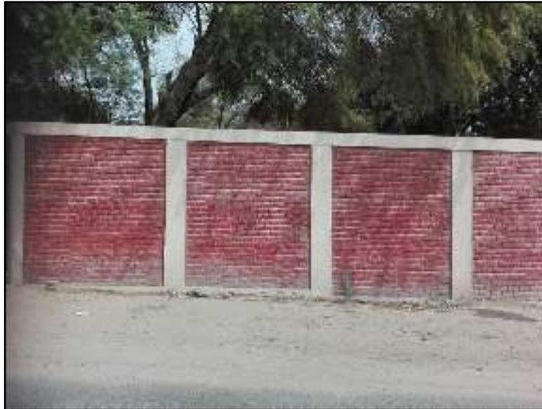
**Grafico 05. Columna y muro de albañilería**
