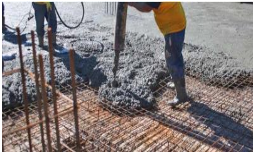
Figura 2. Vaciado de concreto premezclado con bomba. Fuente: Faustino, D. (2005).
