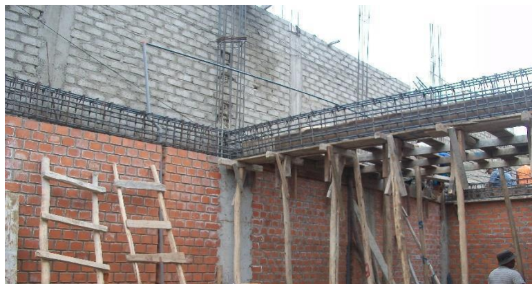
Figura 3. Armadura y encofrado de vigas de concreto armado. Fuente: Yraitá, A. (2016).
