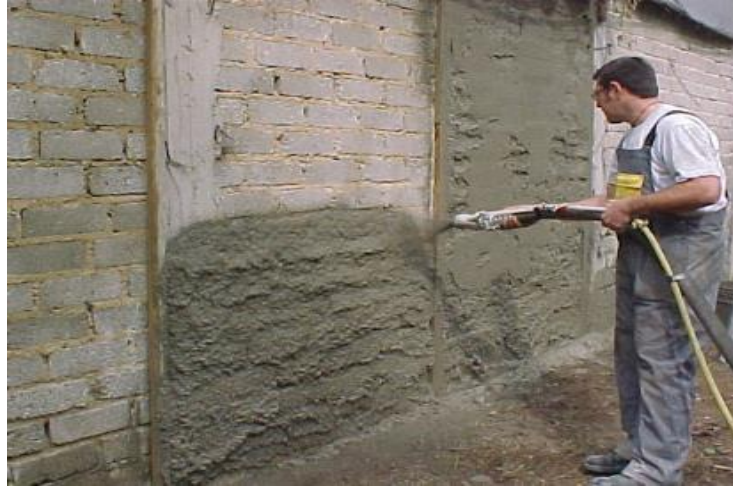
Figura 1. Aplicación de mortero proyectado en muro. Fuente: Oliva, F. (2011).
