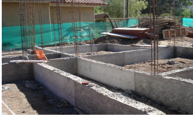
Figura 2. Sobrecimiento de concreto simple. Fuente: Rojas, E. (2016).
