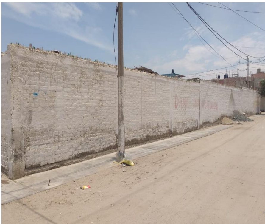
Fotografía 2. Vista panorámica de tramo 1-2 y 2-3 del cerco perimétrico de la Institución Educativa Los Pequeños Traviesos número 1586
