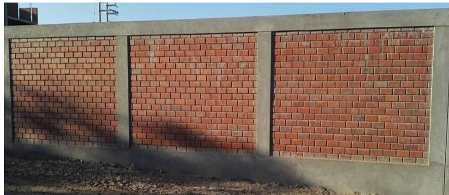
Figura 1. Muro construido con sistema de albañilería confinada. Fuente: Orosco, G. (2016).
