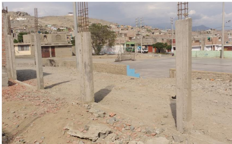
Figura 4. Columnas de concreto armado.
