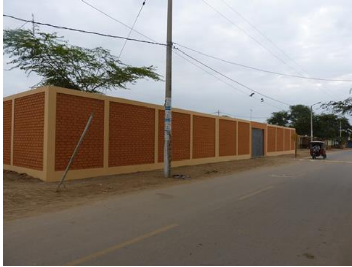
Figura 4. Cerco perimétrico construido con el sistema de albañilería confinada.
