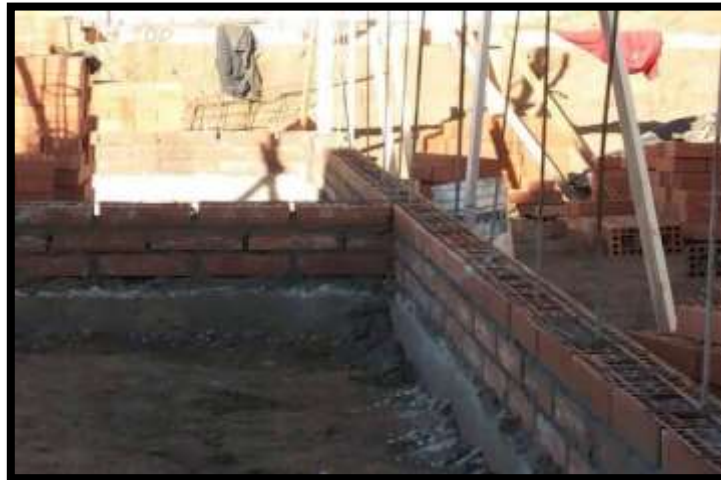
Figura 05: Muros Reforzados o Albañilería Reforzada Fuente: Gómez Cabrera (2014).
