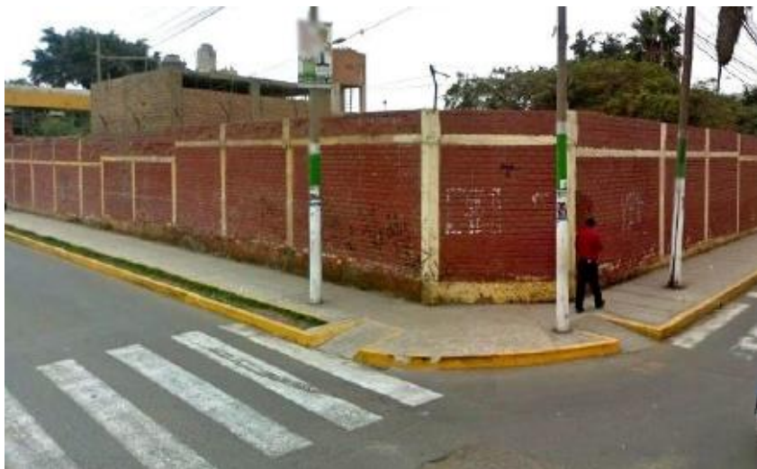
Figura 5. Vista panorámica del exterior en uno de los lados de la I.E Augusto B. Leguía, distrito Puente Piedra, provincia de Lima, región Lima.
