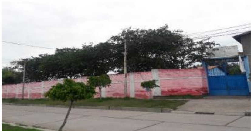
Figura 3. Vista panorámica del cerco perimétrico del instituto Nuestra Señora de Lourdes.
