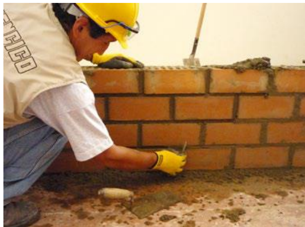
Figura 8. Construcción de muro de arrioste o soga. Nota. Fuente: Sencico (2014).
