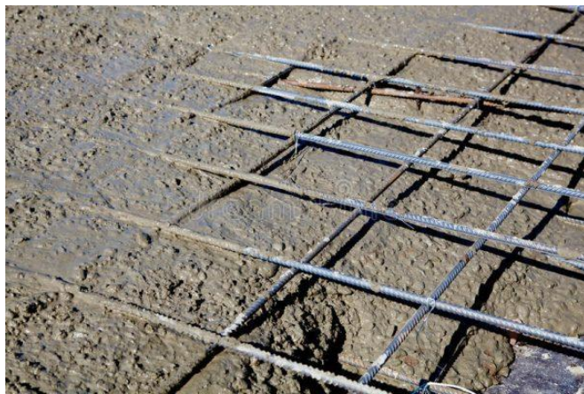
Figura 11. Imagen de concreto armado.
