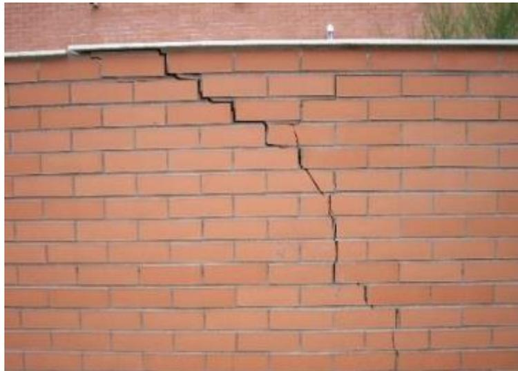
**Figura 14.** Grieta en muro
