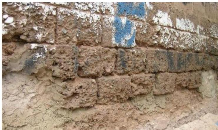
**Figura 11.** Erosión en muro
