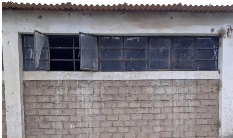
**Figura 8.** Viga de Confinamiento
