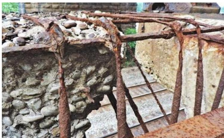
**Figura 16.** Estructura atacada por Corrosión
