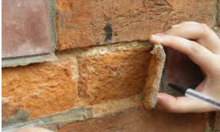
**Figura 12.** Erosión Física
