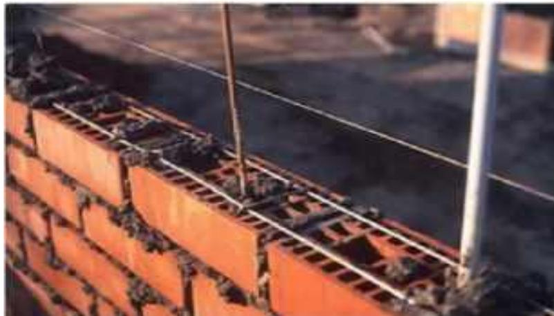
**Figura 5.** Albañilería Armada
