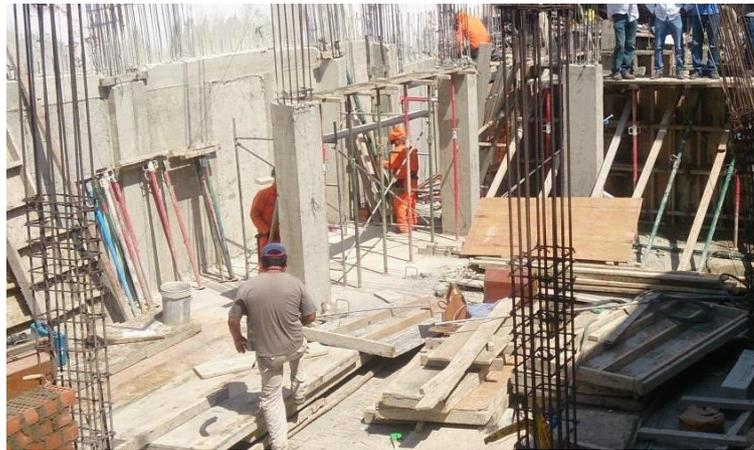
*Figura 7.* Columnas de Concreto Armado
