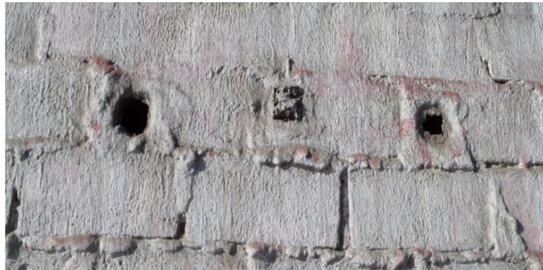
**Figura 75.** Erosión Mecánica en muro
