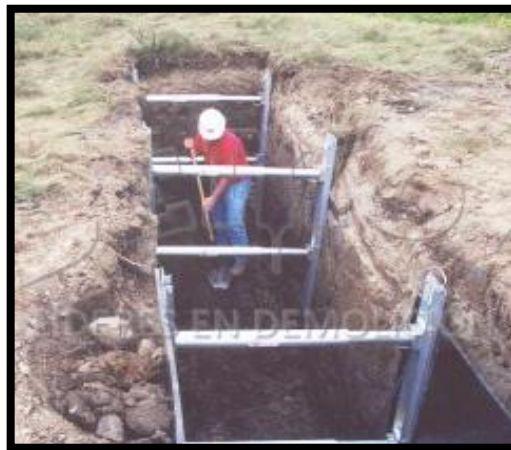
Imagen 05: Entibados para evitar deslizamientos.
