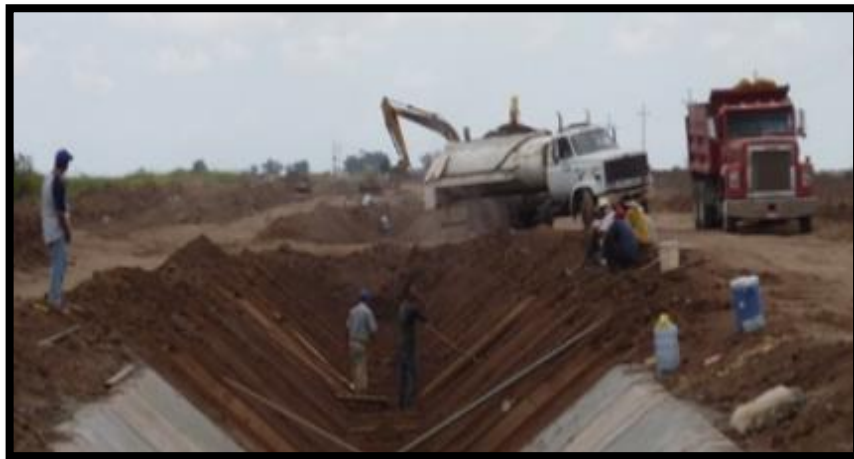
Imagen 06: Formación de Taludes.
