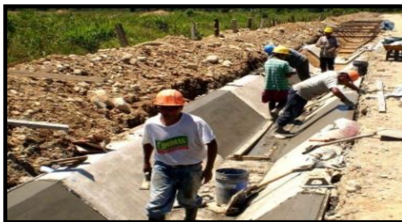
Imagen 9: Colocación del Concreto en el Canal.
