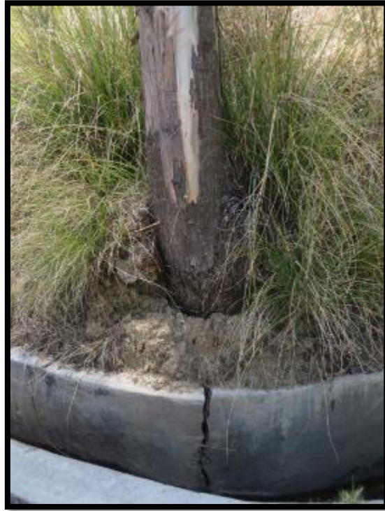
Imagen 23. Grietas ocasionadas por el empuje de los terrenos
