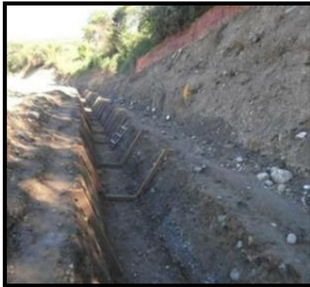
Imagen 8: Colocación de las Cerchas en el Canal.
