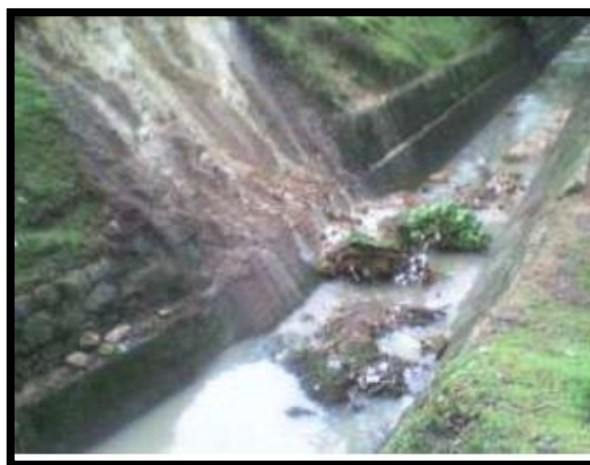
Imagen 16: Presencia de Musgos en las paredes del Canal.
