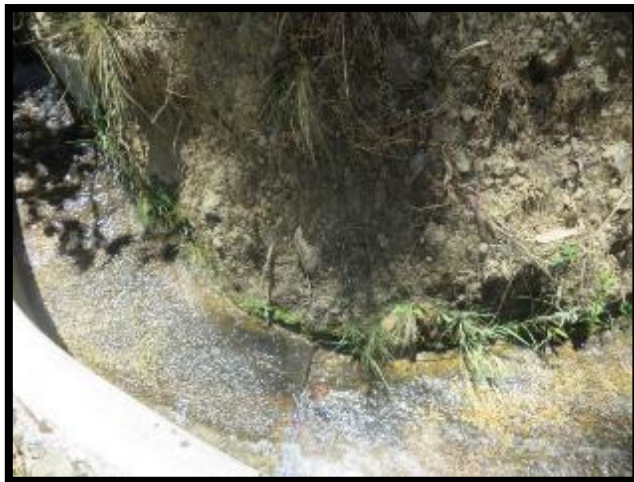
Imagen 26. Parte del canal sin elemento
