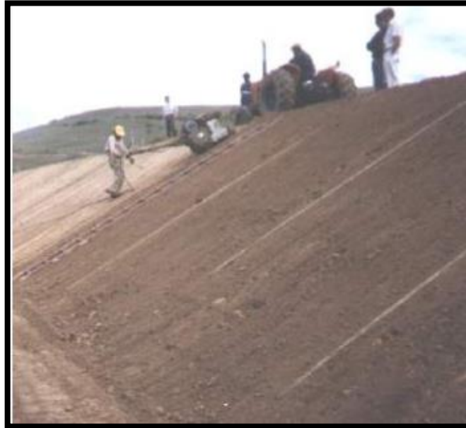
Imagen 07: Compactación de los taludes del Canal.
