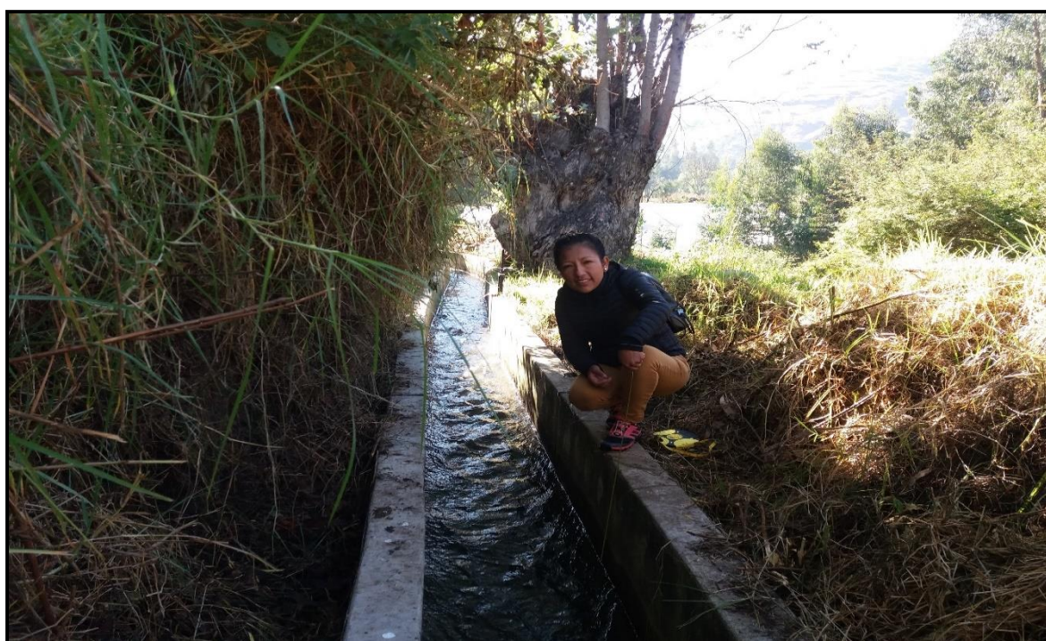
Fotografía N° 04: Vista del entorno del canal, realizando mediciones.
