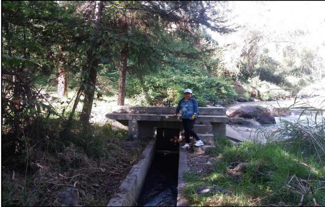
Fotografía N° 01: Canal 2, progresiva 0+000 km del Distrito de Marcará.
