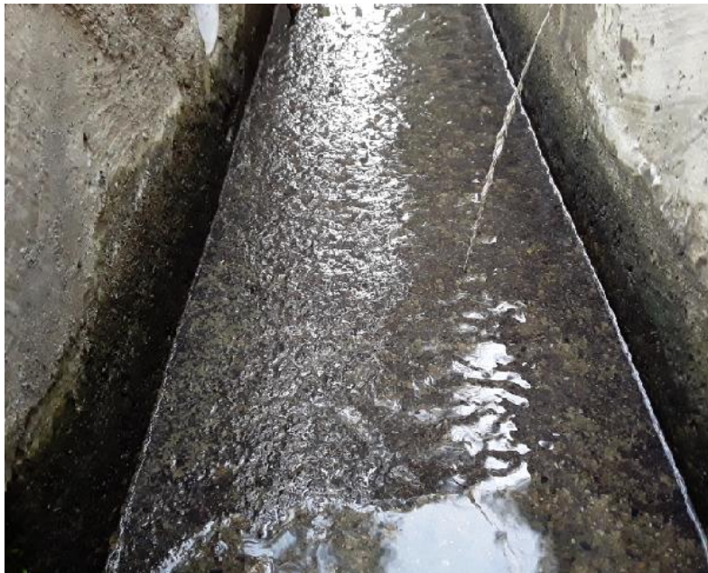
Erosión en piso de canal.
