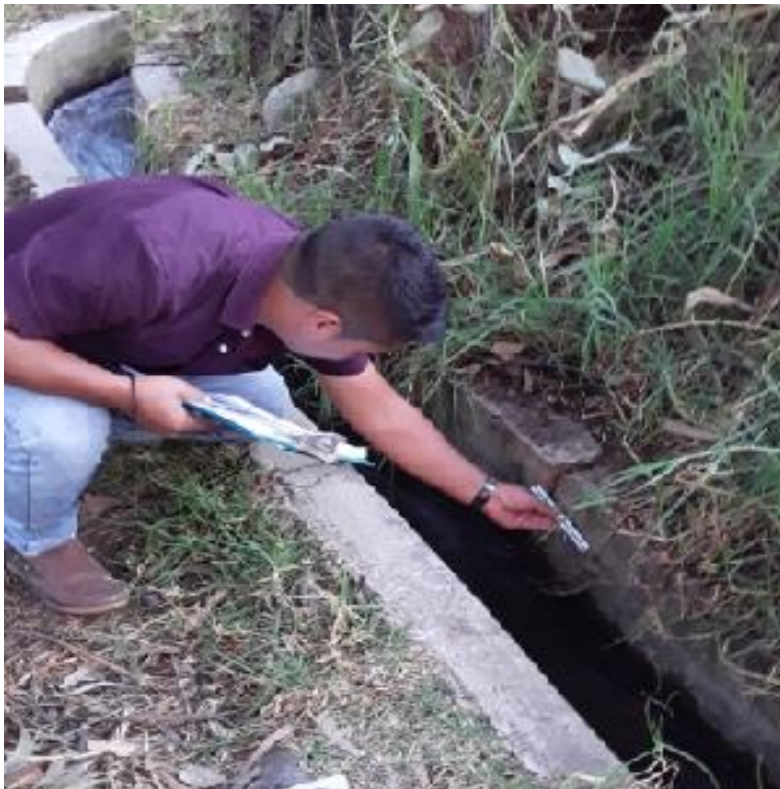
Grieta en canal.
