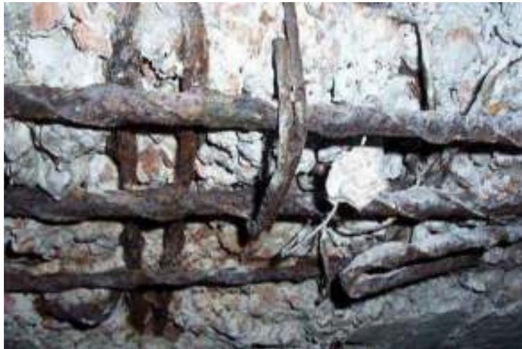
*Figura 15: Corrosión.*
