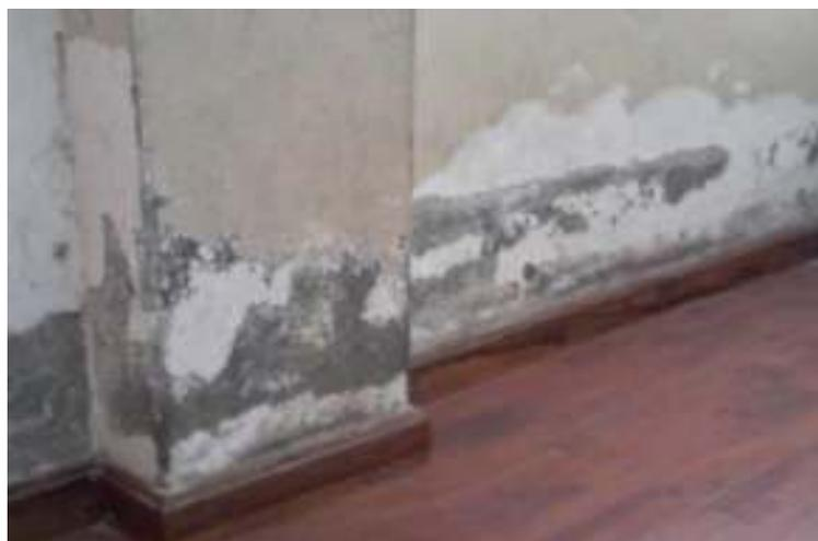
*Figura 14: Eflorescencia en el concreto.*
