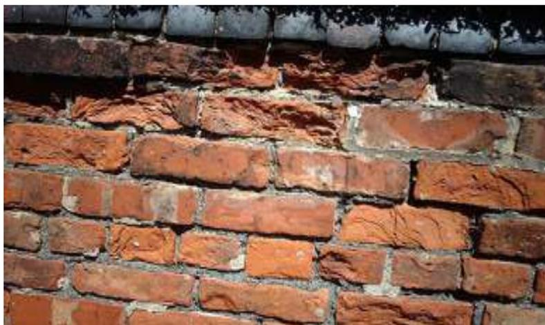
*Figura 9:* Erosión mecánica.
