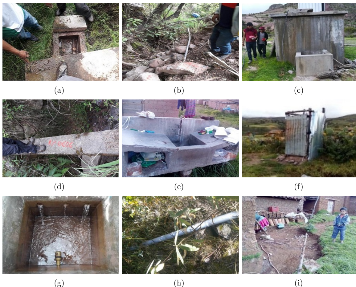
Figura 1: Descripción de los componentes del proyecto: (a) Captación - San Martín de Pampamarca, (b) y (c) Línea de conducción, (d) Reservorio, (e) Conexiones domiciliarias, (f) Unidades básicas de saneamiento, (g) Captación - Collpa, (h) Tuberías a la interperie y (i) Red de distribución a la interperie.
