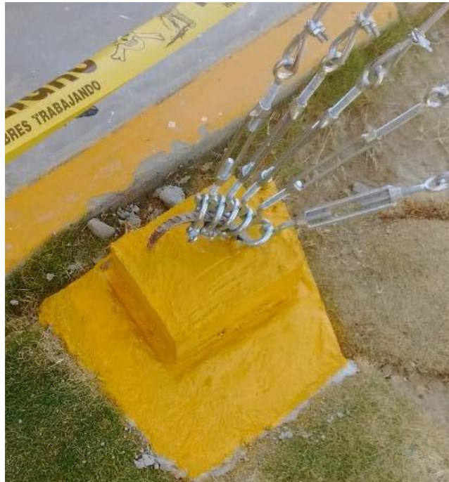
Gráfico N° 26: Diseño de Ancla
