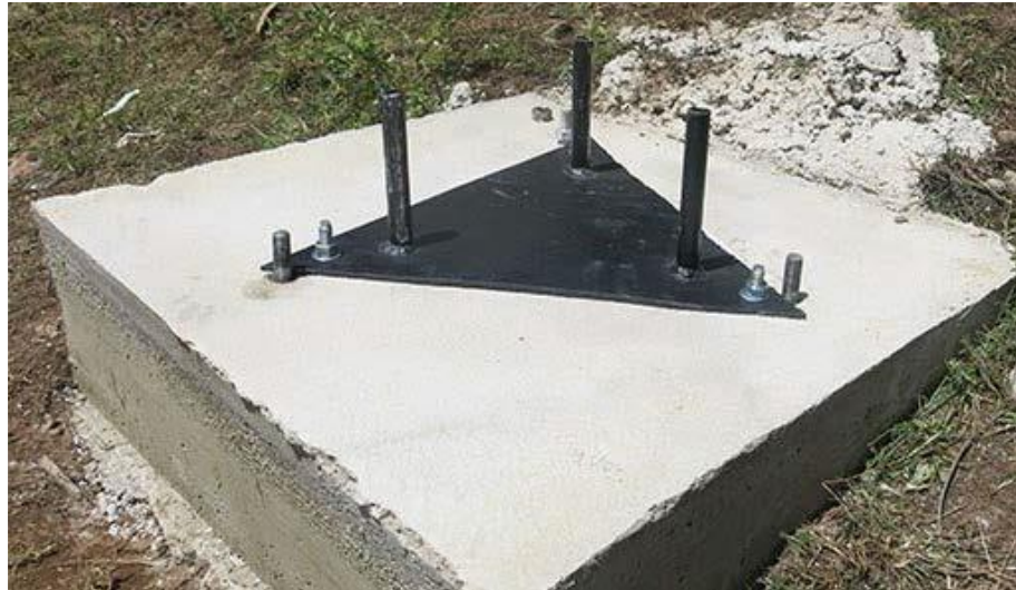
Gráfico N° 27: Diseño de Base Torre
