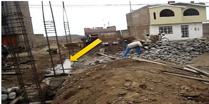
Gráfico 6: Detalle de vaciado de los cimientos corridos Nota Fuente: Vazallo F. (2016).
