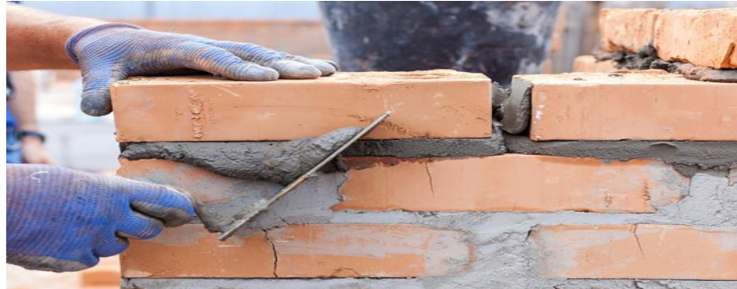
Gráfico 10: Detalle del uso del mortero en el asentado del ladrillo.
