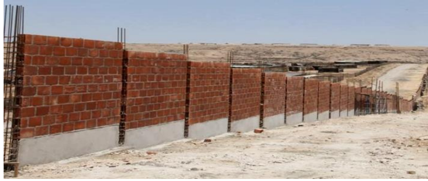
Gráfico 3: Construcción del cerco perimétrico Nota. Fuente: Gobierno Regional de Arequipa. (2016).
