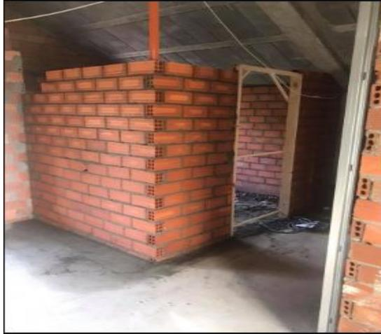
*Imagen 2 albañilería simple sin presencia de columnas*
