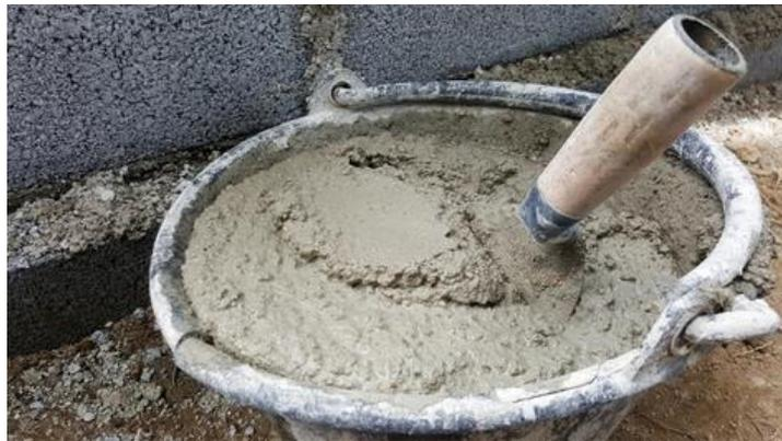
*Imagen 12 mortero con impermeabilizante
