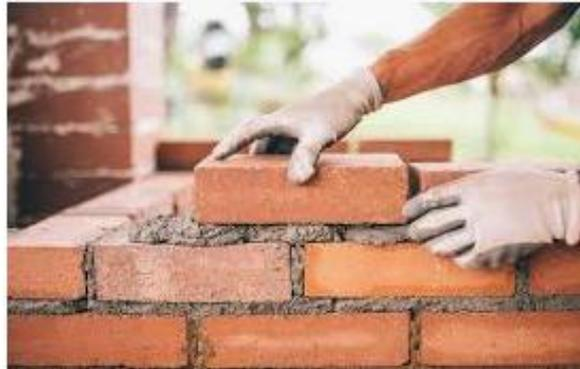
*Imagen 1 asentado de ladrillo en albañilería
