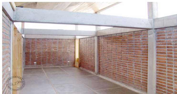
Figura 3. Albañilería Confinada Nota. Fuente: (Pérez A. EcuRed. 2015) (8)
