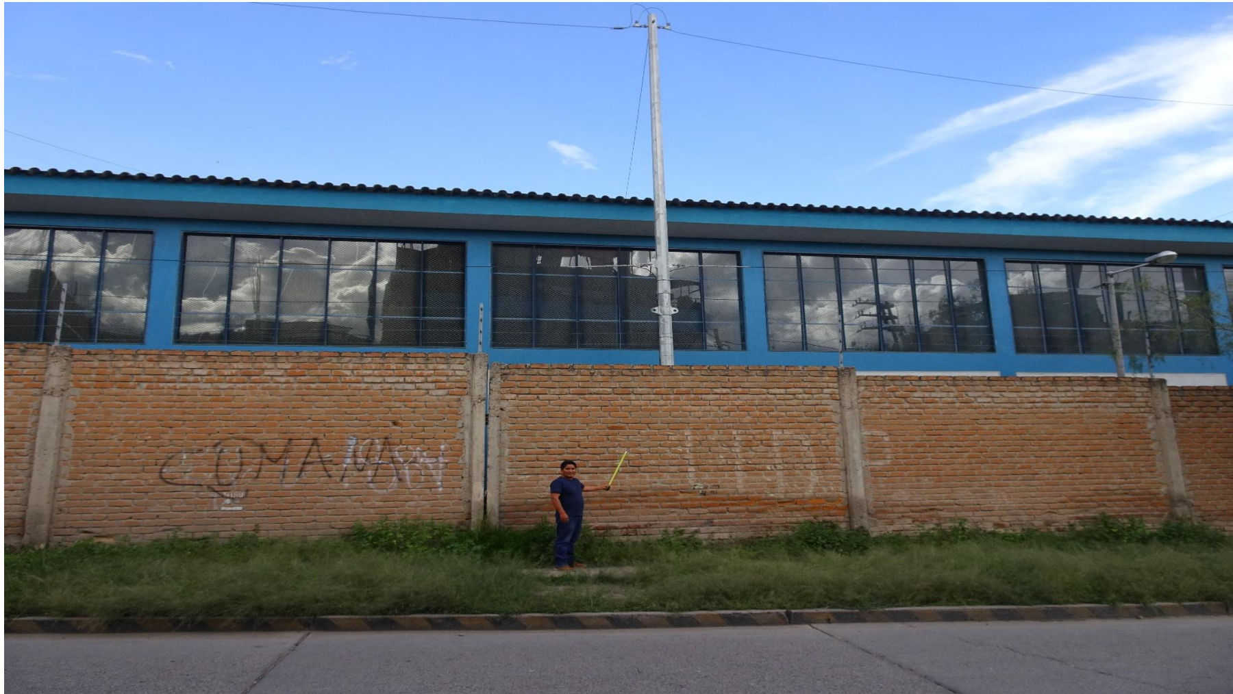
Fotografía 2: Tramo A–B del cerco perimétrico de la Empresa ELECTROCENTRO S.A. Ayacucho, ubicado en la Av. Del Deporte N° 400 - Ayacucho, provincia de Huamanga, región de Ayacucho.
