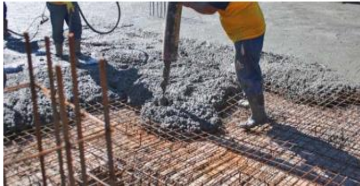
Figura 9. Concreto Armado. Nota. Fuente: (Faustino D. 2005) (17)
