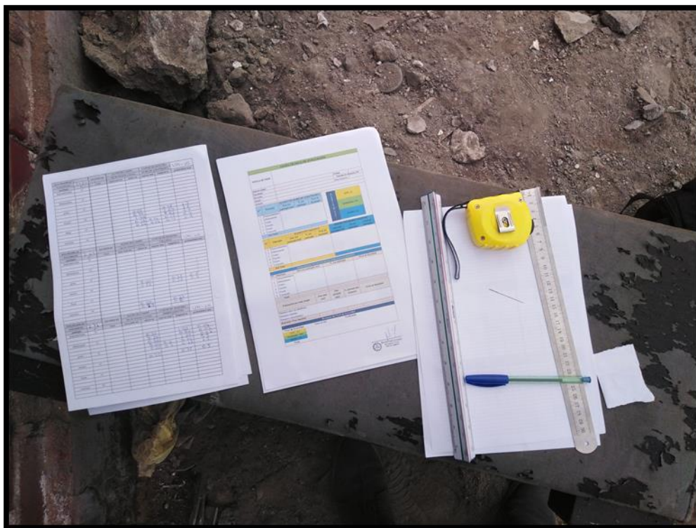
Fotografía de los instrumentos, materiales y herramientas de trabajo utilizados en el cerco perimétrico del almacén de cueros ubicado en la manzana s1, lote 6, en el Distrito de Chorrillos, Provincia Lima, Región Lima - febrero 2019.
