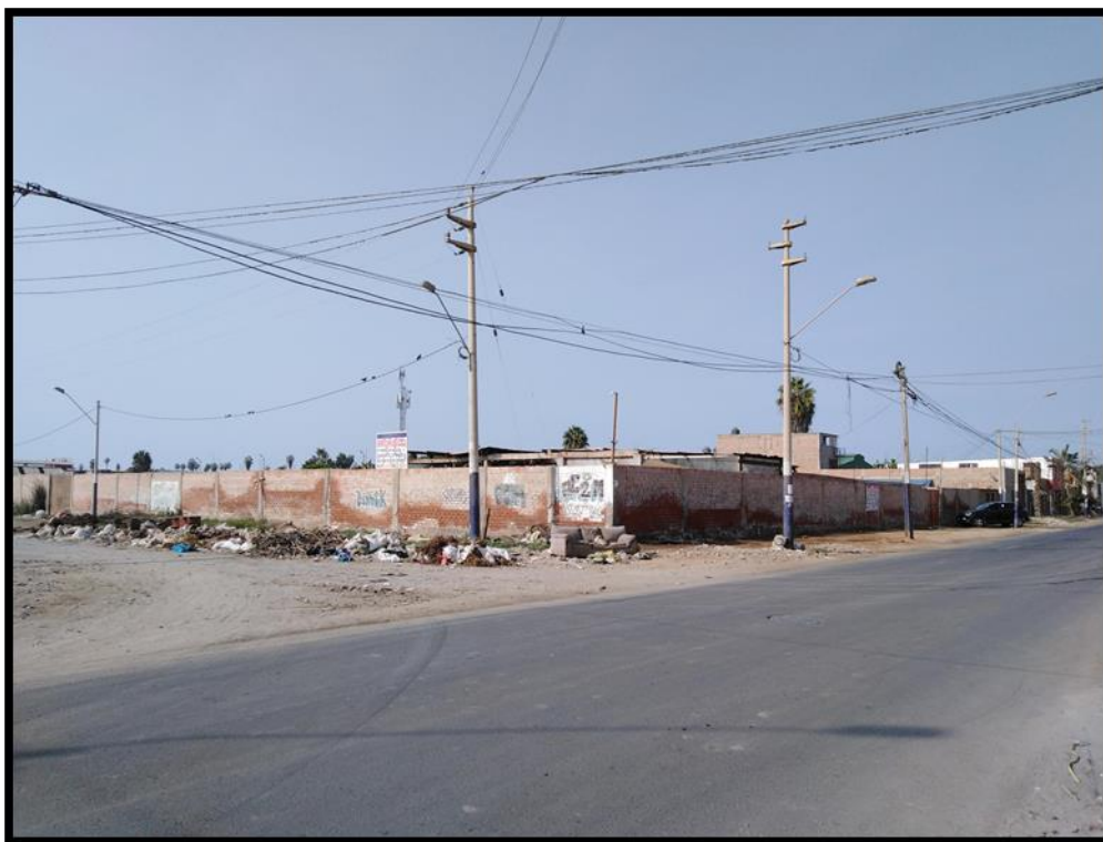
Fotografía del cerco Perimétrico del almacén de cueros ubicado en la manzana 51, lote 6, en el Distrito de Chorrillos, Provincia Lima, Región Lima - febrero 2019.
