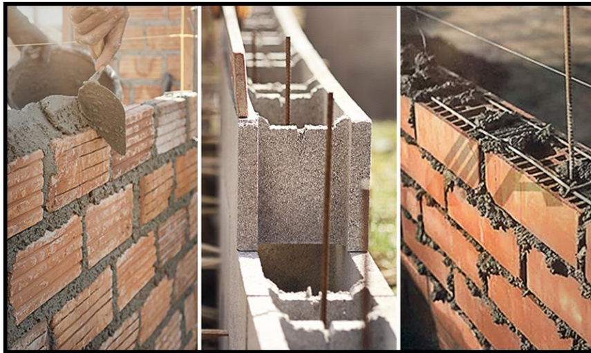
Figura 6: Albañilería Fuente: Caliza Cemento Inca S.A.
