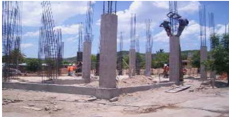
Figura 02. Columnas de Concreto Armado
