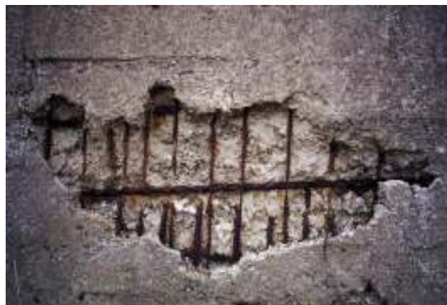
Figura 08. Corrosión
