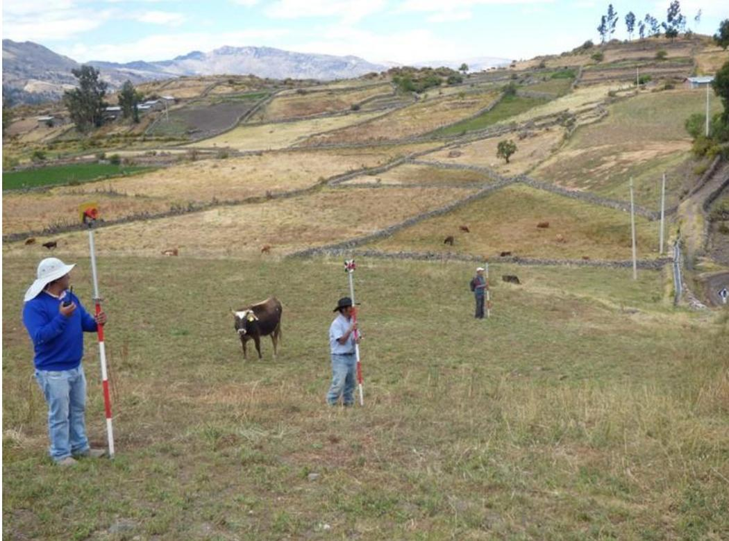
Figura 4.4: Levantamiento topográfico de la línea de conducción.
