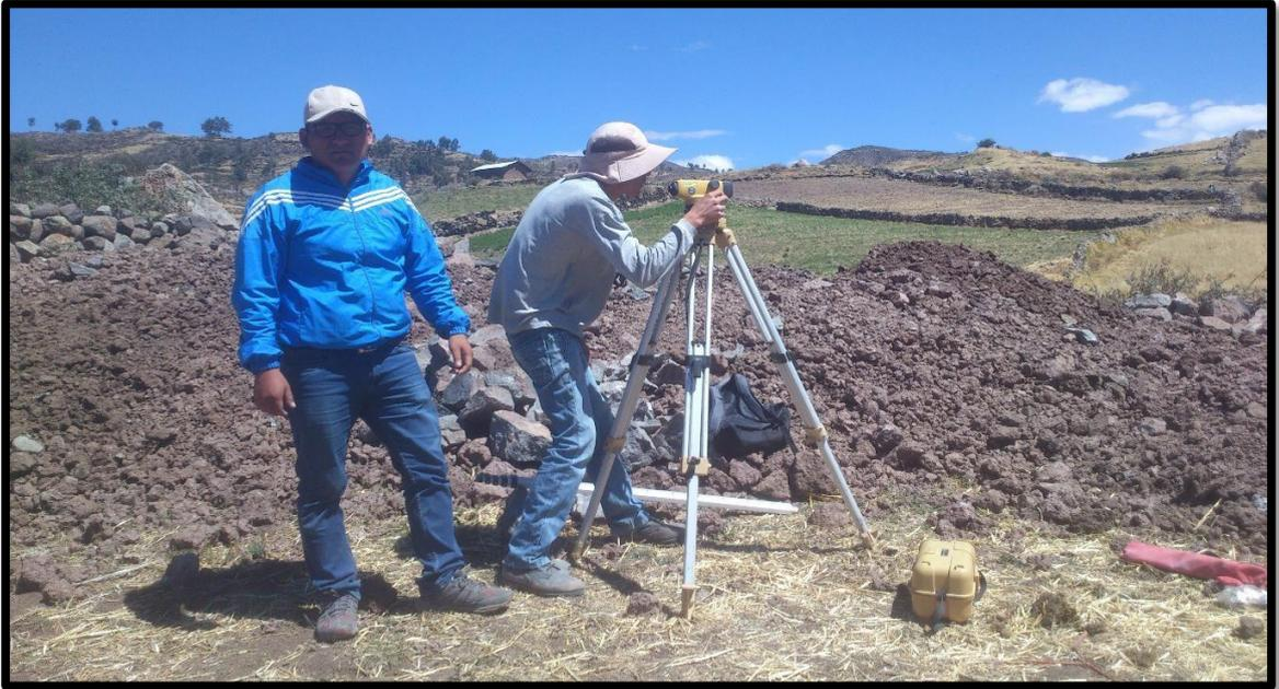
**Foto 03: Levantamiento topográfico para ubicar el Reservorio.**
