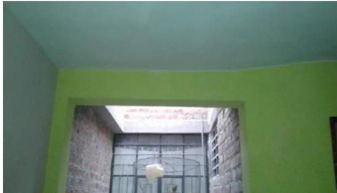
Figura 2: Imagen de viga Fuente: Elaboración Propia.
