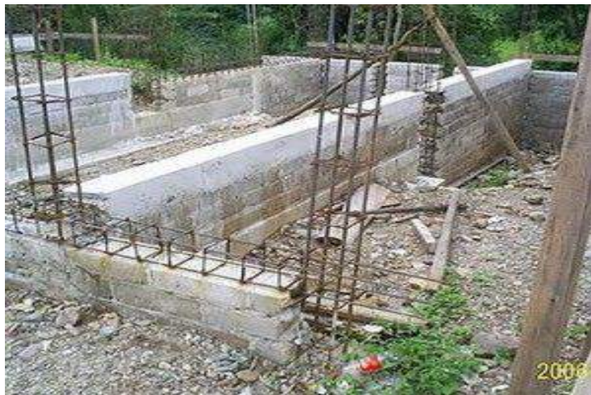
Figura 3: Imagen de sobrecimiento. Fuente: Arqhys Arquitectura.
