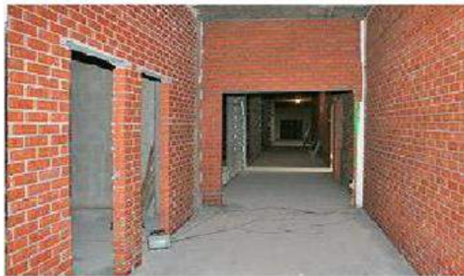
Figura 4: Imagen de muro. Fuente: Catcoparco H.
