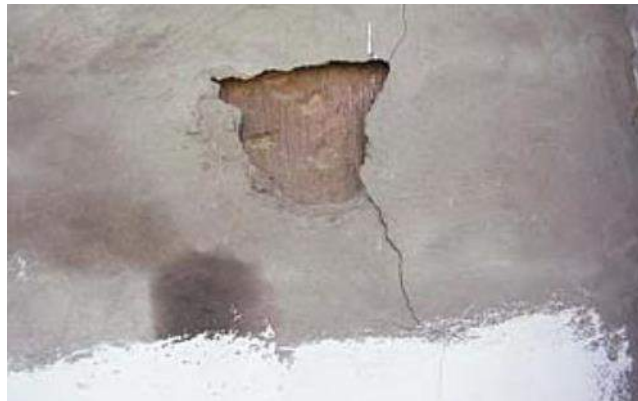
Figura 12: Imagen de desprendimiento. Fuente: Construmática
