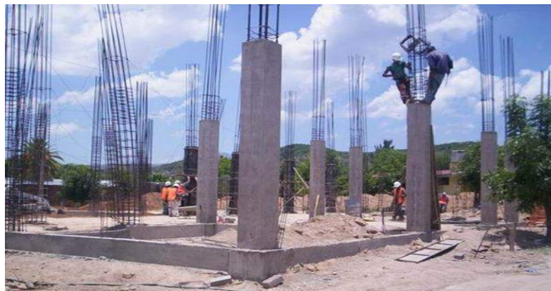
Figura 1: Imagen de columna. Fuente: Arqhys Arquitectura.
