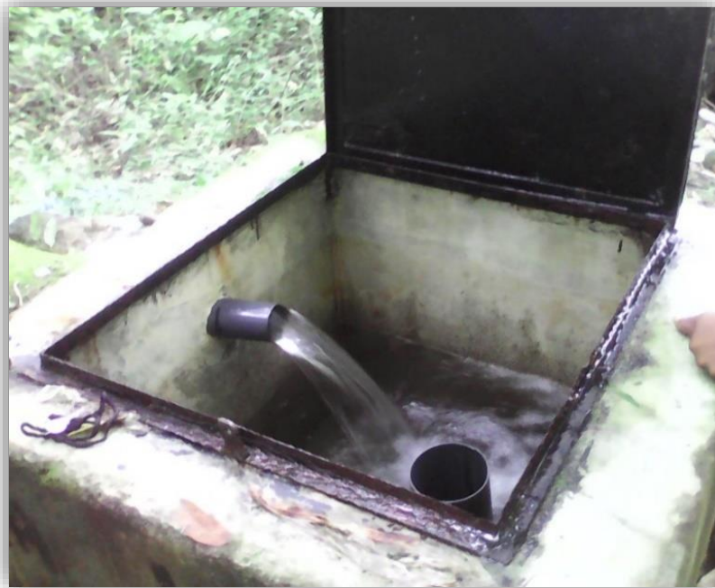
Fotografía 7. Cámara recolectora del caudal. Fuente: Elaboración propia
