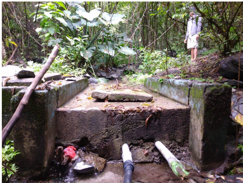
Fotografía 6 vista lateral de la Captación. Fuente: Elaboración propia
