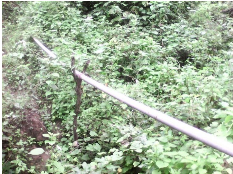
Fotografía 8. Tramo línea de conducción si adecuado pase aéreo Fuente: Elaboración propia.
