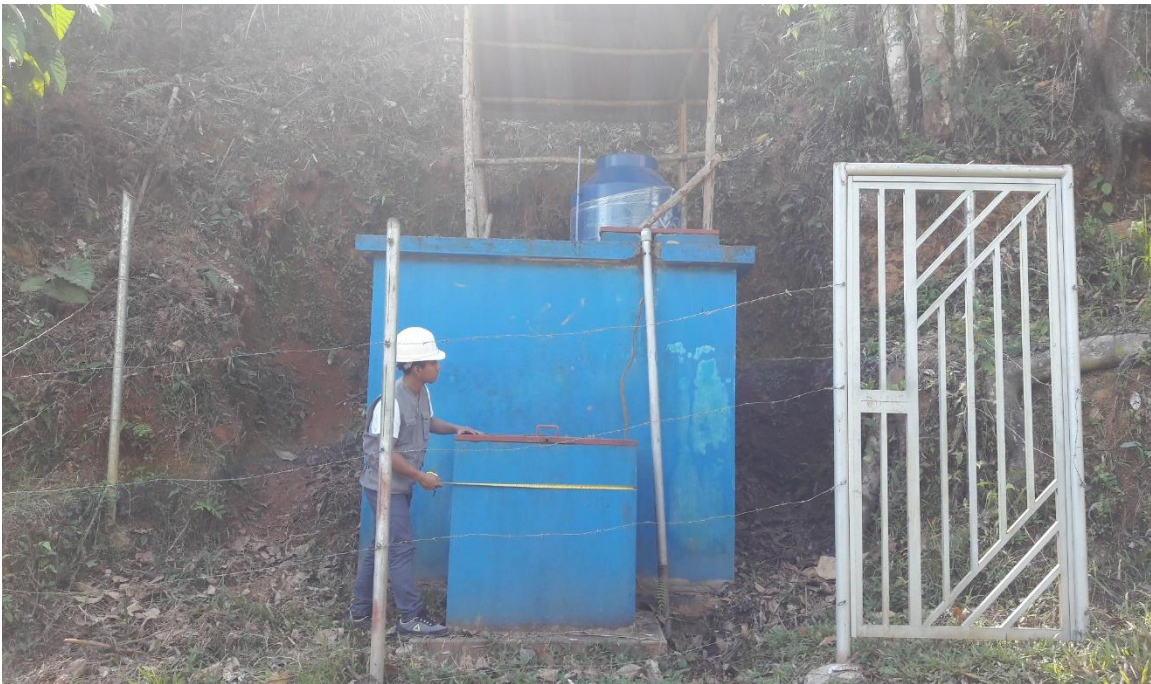
Figura 42. En esta imagen se puede apreciar la verificación del estado situacional del Reservorio del sistema de agua potable en el Anexo Alto Tzancuvatziri.
