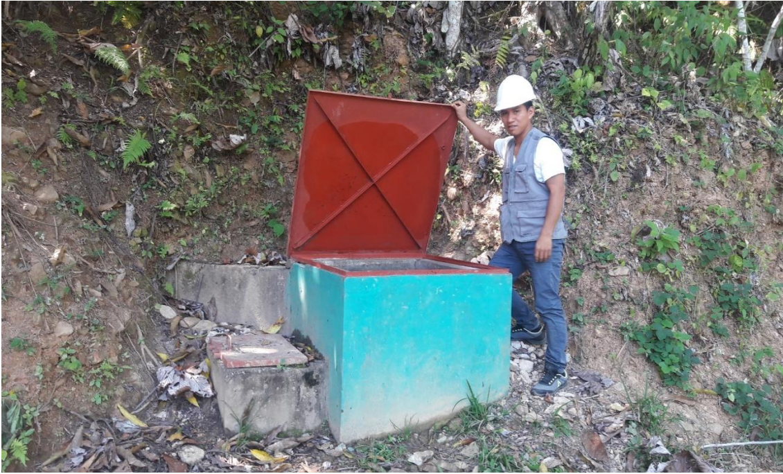
Figura 41. En esta imagen se puede apreciar la verificación del estado situacional de la captación del sistema de agua potable en el Anexo Alto Tzancuvatziri.
