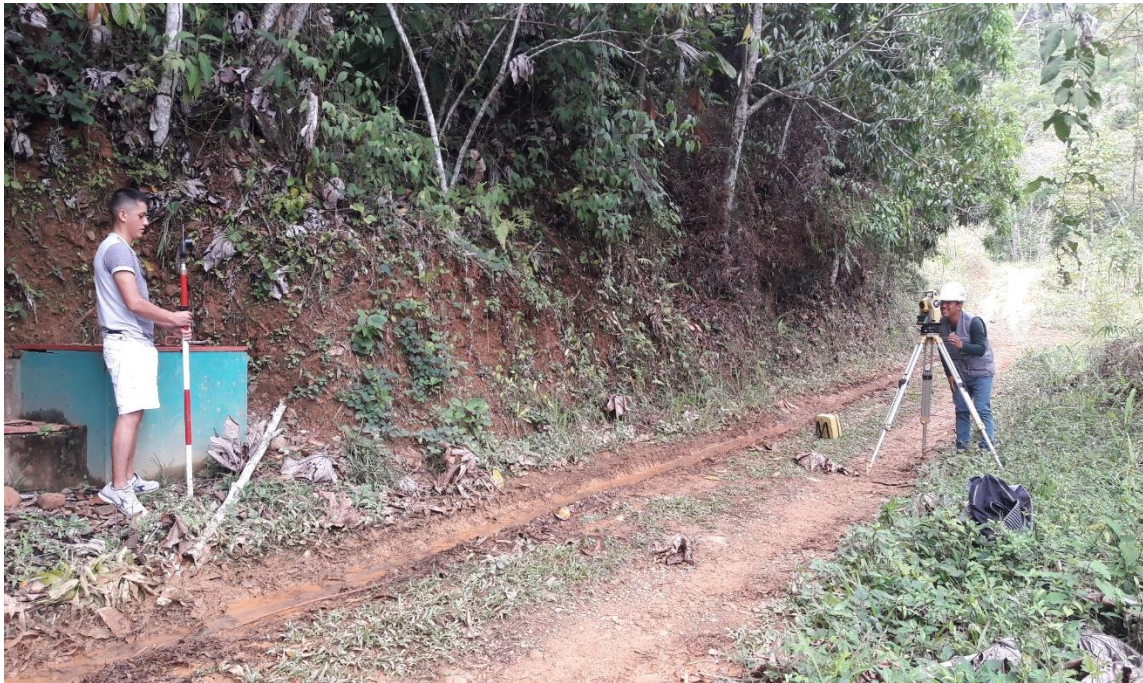
Figura 49. En esta imagen se puede observar realizando levantamiento topografico en el sistema de Agua potable
