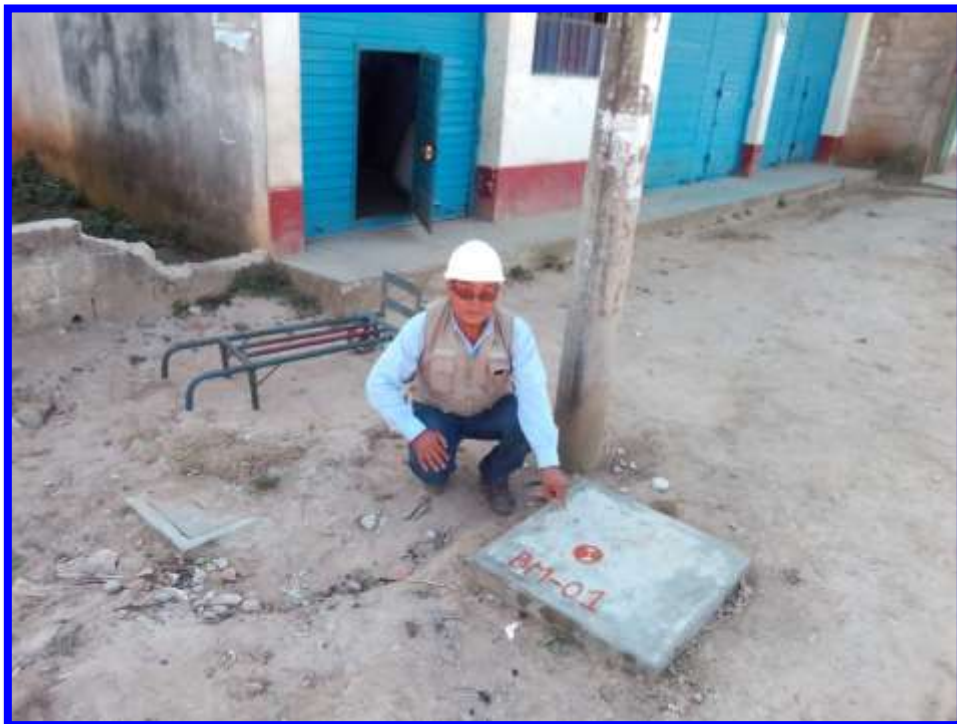
Foto N° 04.-Ubicación de BMs referenciales.
