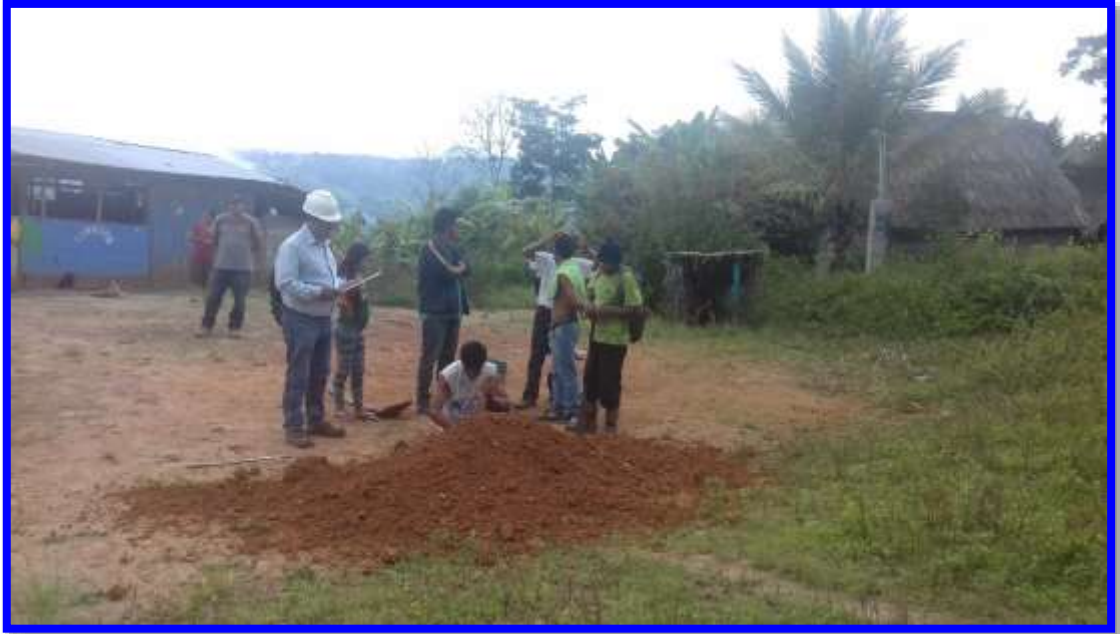
Foto N° 05.-Elaboración de calicata para el estudio de suelos.
