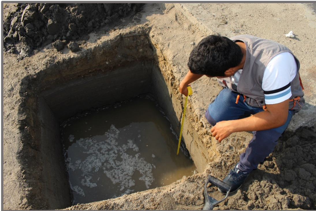
Fotografía 20: En la calicata que encontró el nivel freático a 75 centímetros de profundidad.
