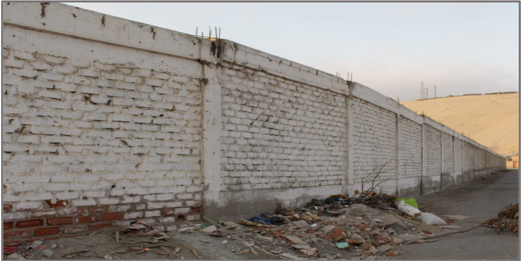
Fotografía 02: Vista del cerco perimétrico exterior eje 1-1 del cerco perimétrico del estadio municipal José Céspedes Bravo del distrito de Salaverry, provincia de Trujillo, región la Libertad.
