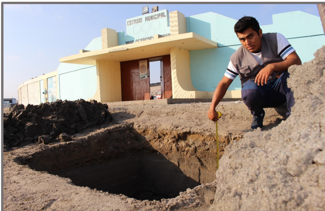
Fotografía 21: Calicata de 1.50 m x 1.50 m ubicada al costado del cerco perimétrico del estadio municipal José Céspedes Bravo.
