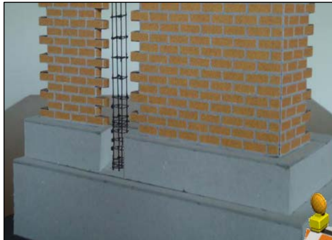
Imagen 10. Proceso constructivo del sobrecimiento
