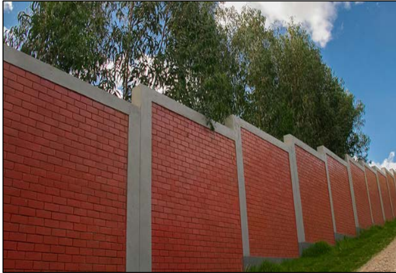
Imagen 2. Cerco perimétrico de albañilería confinada
