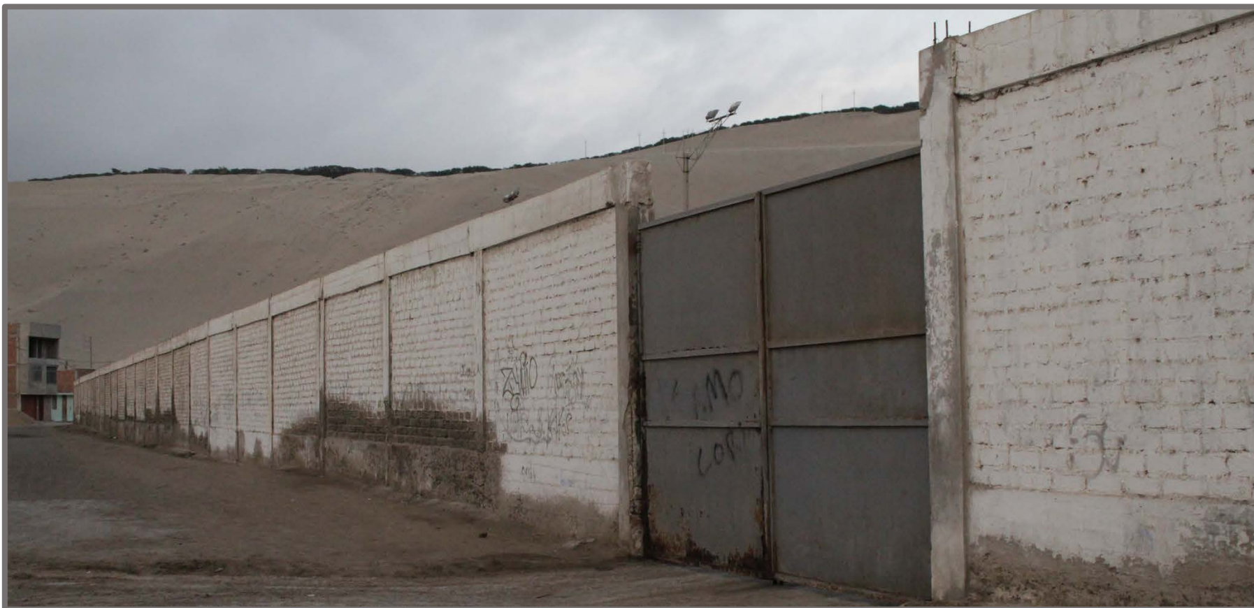
Fotografía 04: Vista del cerco perimétrico exterior eje 3-3 del cerco perimétrico del estadio municipal José Céspedes Bravo del distrito de Salaverry, provincia de Trujillo, región la Libertad.
