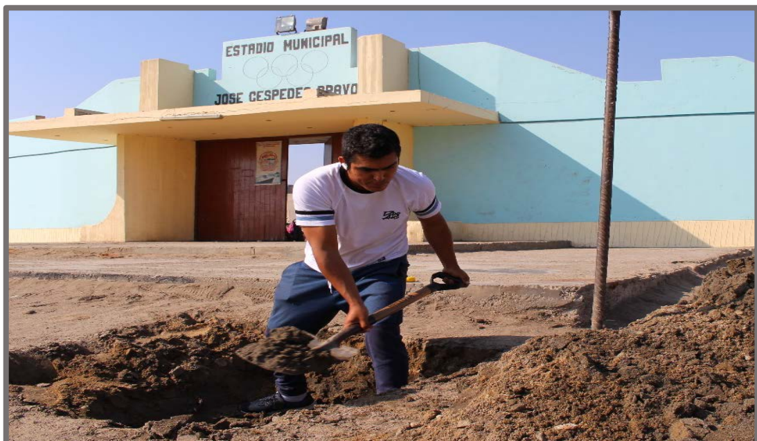
Fotografía 19: Excavación de calicata 1.50 x 1.50 metros.
