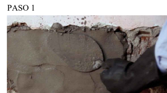
Luego de aplicar el mortero con una espátula, se procederá darle una forma lisa con una regla y frotachar la superficie para terminar.
