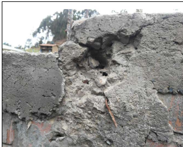
Imagen 23. Erosión mecánica
