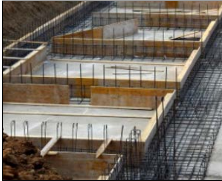
Imagen 5. Estructura de concreto armado
