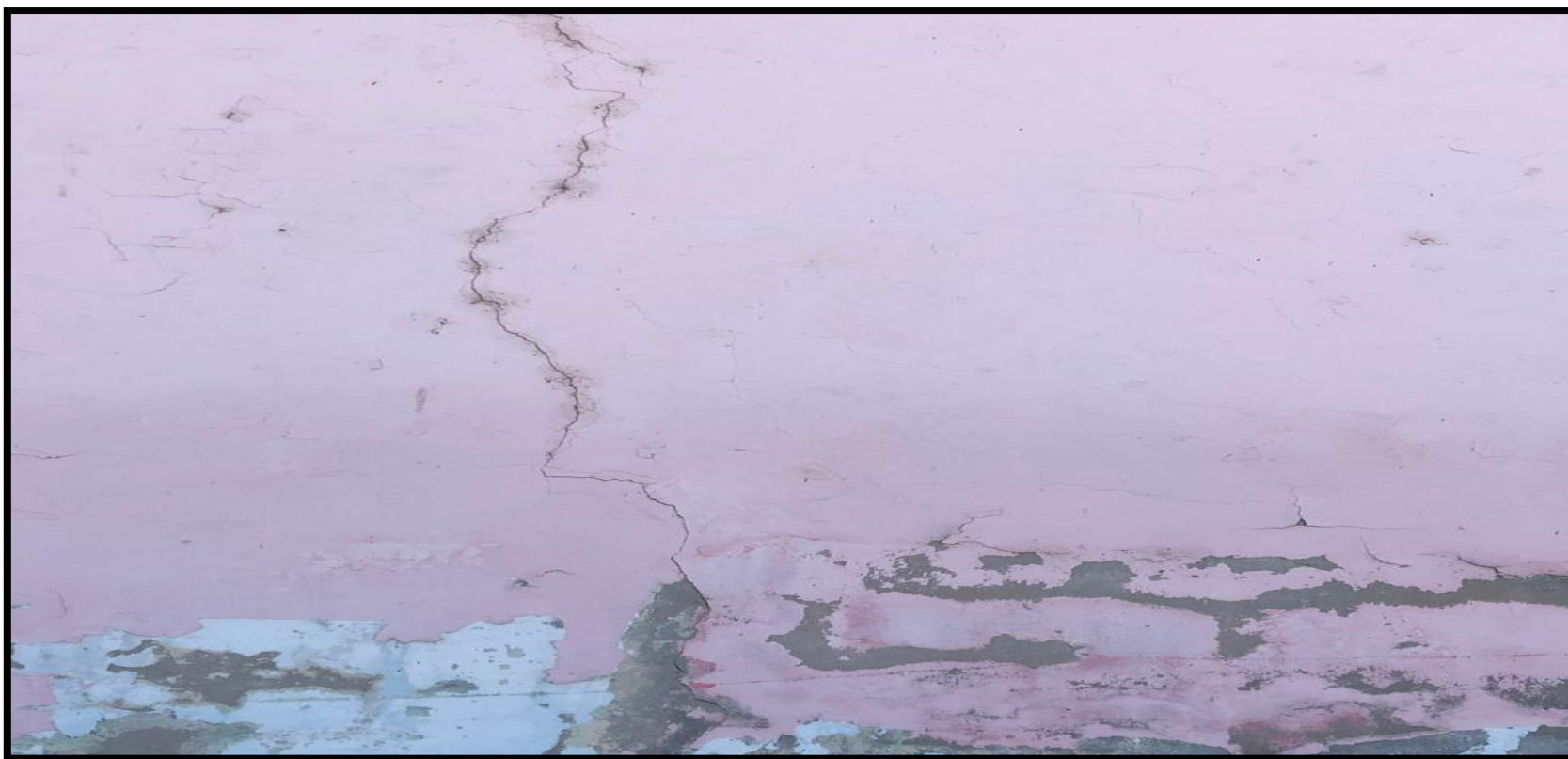
Fotografía 06. Presencia de fisura en muro – Unidad muestral 04.
