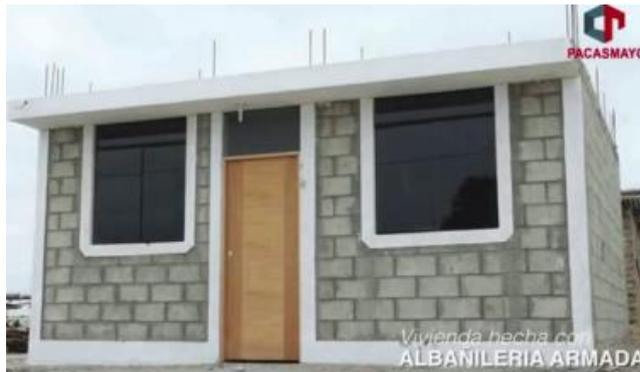
Figura 7. Vivienda de albañilería armada
