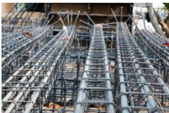
Figura 9. Acero reforzado para columnas
