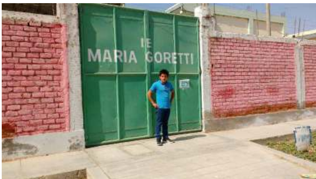
Fotografía de evaluación patológica frente a la entrada de la institución educativa.
