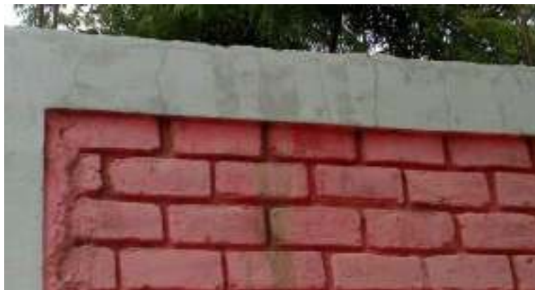
Grafico 2: Fisuras en viga.
