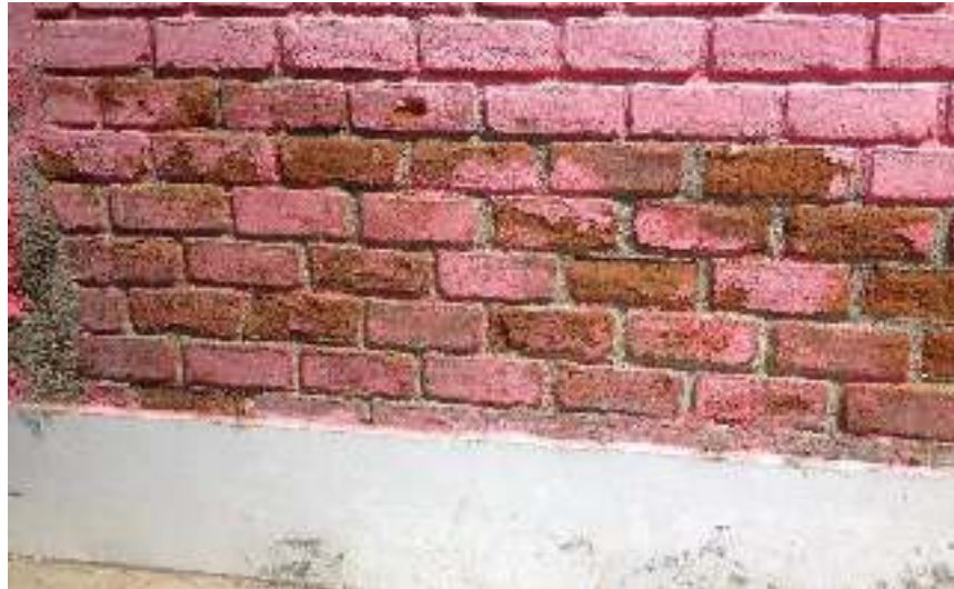
Grafico 7: Ladrillo erosionado.
