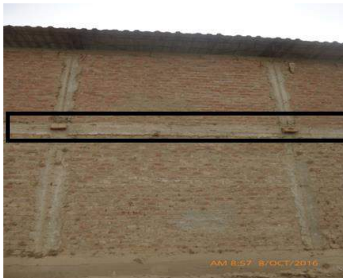
Figura 08 :Vista de viga Cerco perimetrico Coliseo el Salitre. Fuente : Propia (2016)
