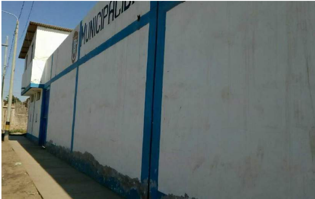
Vista de muros exteriores muestra N°16 ,17y 18 del cerco perimétrico del Coliseo el Salitre del Distrito de Catacaos.
