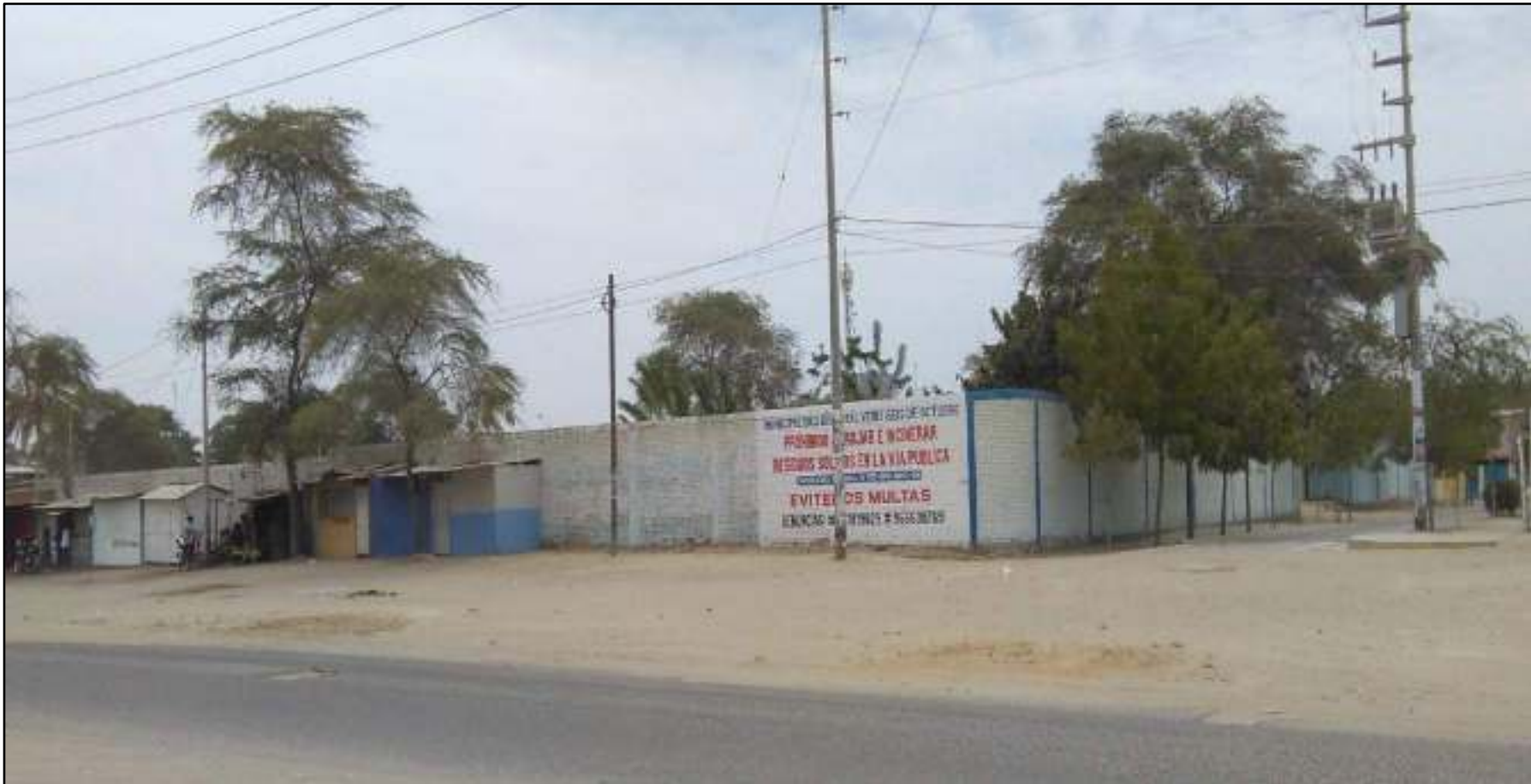
Figura 167: Foto panorámica del cerco perimétrico de la Institución Educativa Inicial 1392, Asentamiento Humano Las Capullanas, Distrito Veintiséis de Octubre, Provincia de Piura, Región Piura, Julio-2016.
