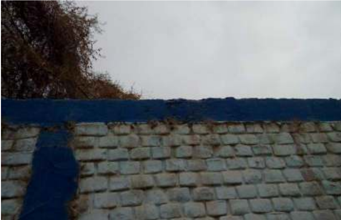
Figura 174: Grieta en viga
