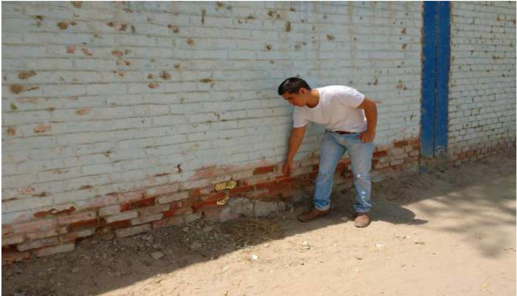
Figura 170: Fotografía donde se identifica la patología erosión
