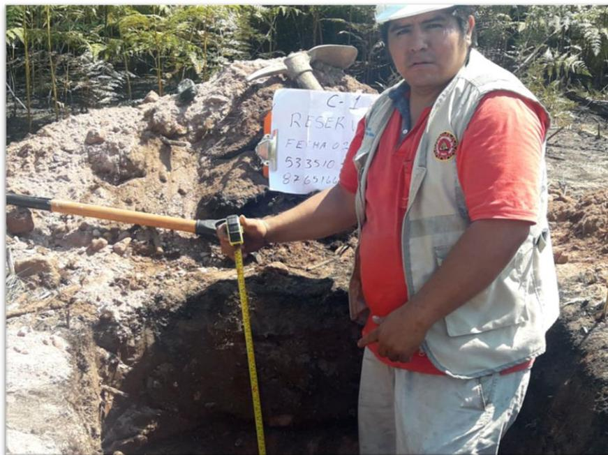
**Fotografía 07:** Vista de la excavación de la calicata de reservorio
