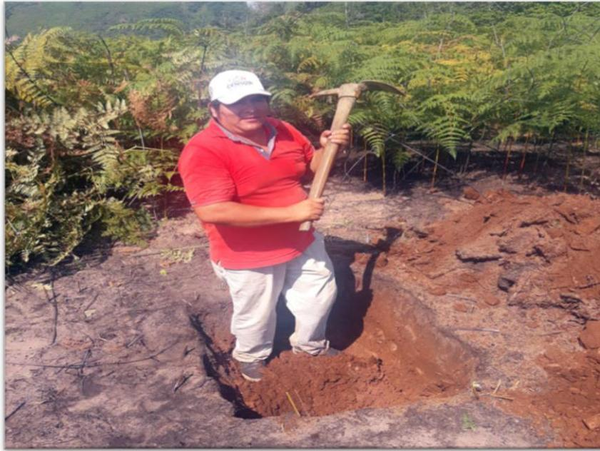
Fotografía 05: Realizando la excavación de calicata del reservorio para el análisis de suelo
