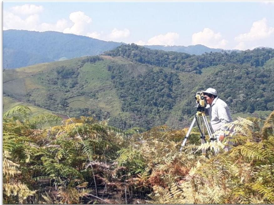
**Fotografía 09:** Vista levantamiento topográfico en la línea de aducción
