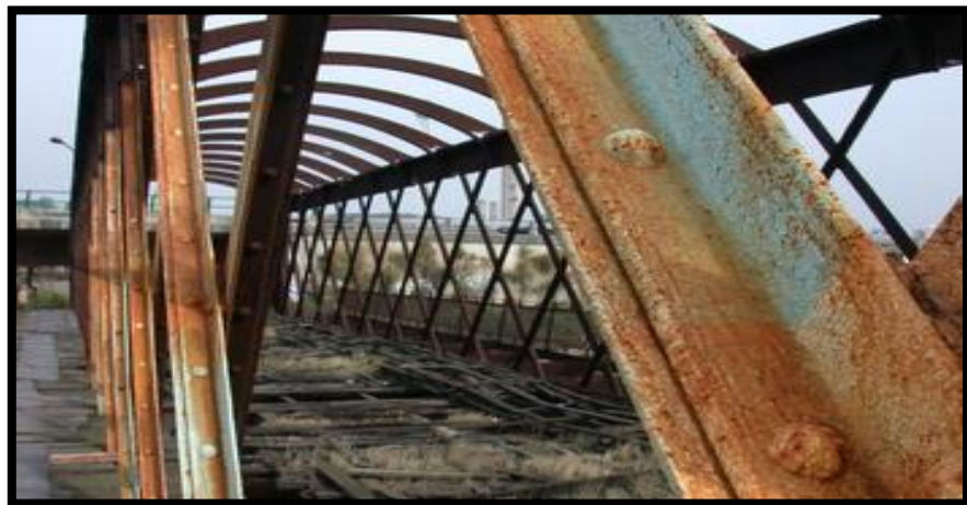
Figura 20 Corrosión.
