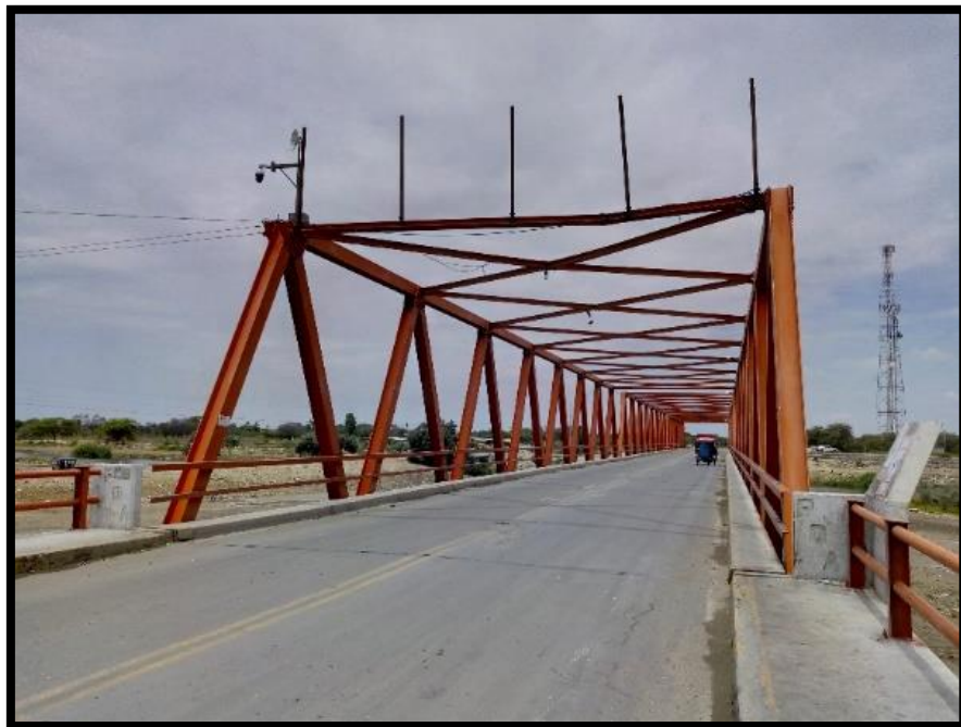
Figura 31. Fotografía de evaluación de los elementos del Puente Sechura Fuente: Elaboración Propia.
