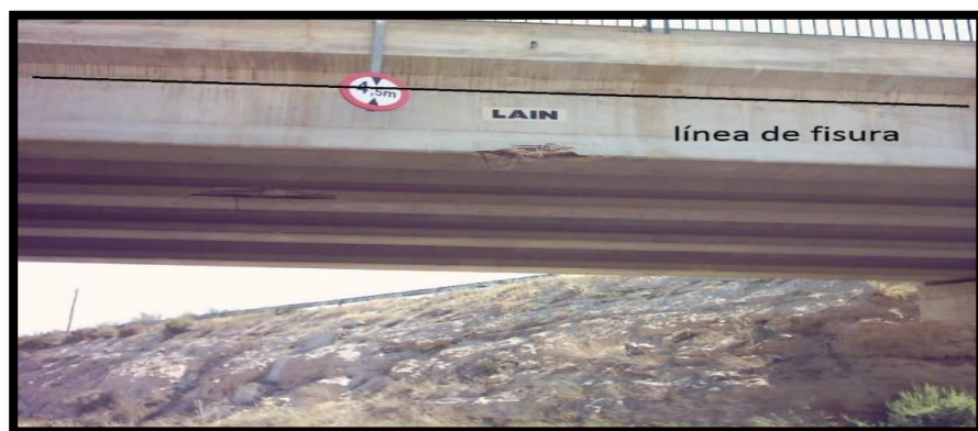
Figura 18 Erosiones mecánicas. Fuente. Blog de Hidrodem.
