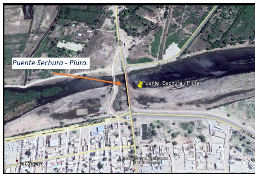
Figura 29 Ubicación del Puente Sechura. Fuente: google earth Perú Piura Sechura.
