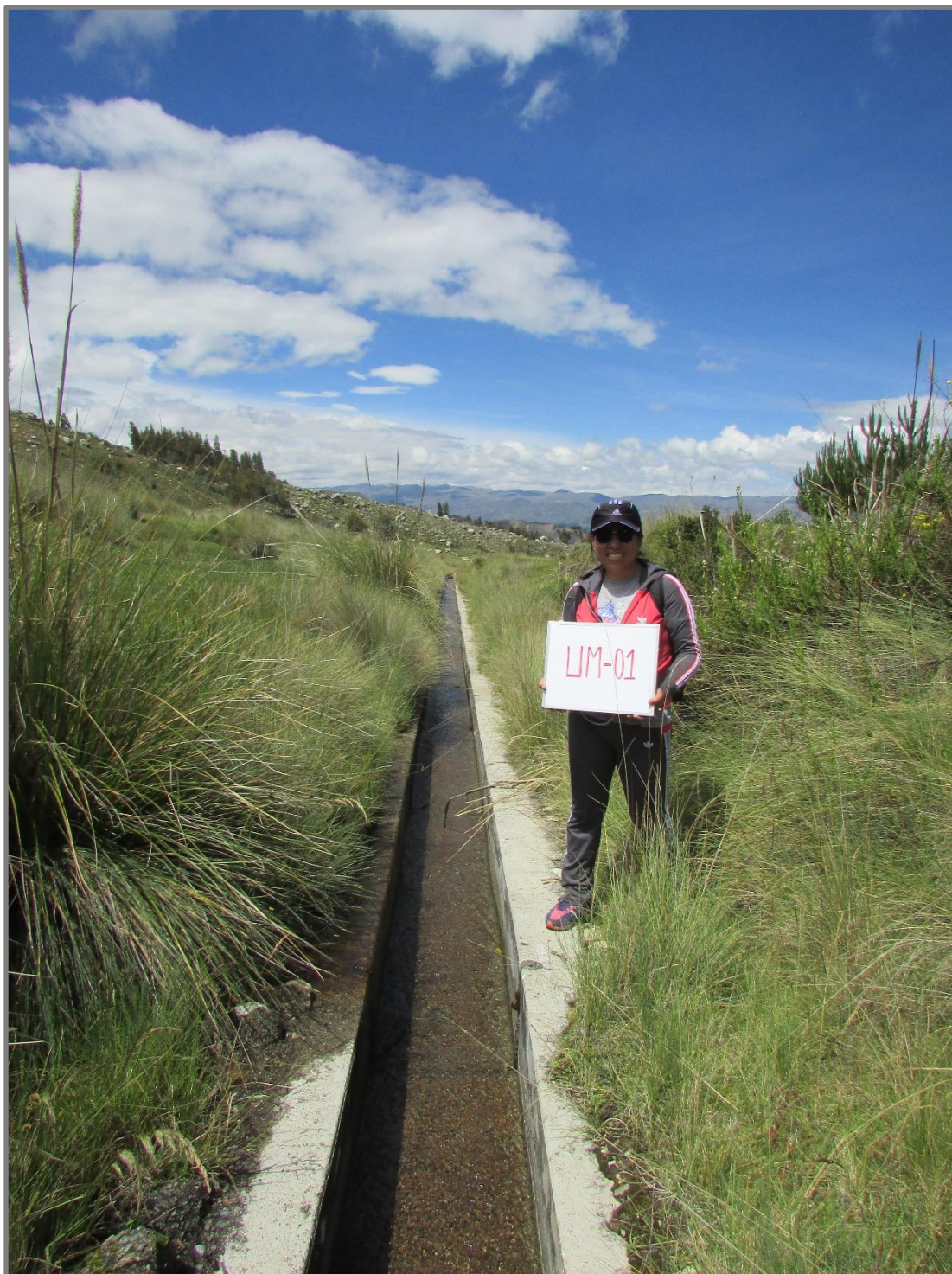
Fotografía 1. Tramo inicial del canal progresiva 0+500
