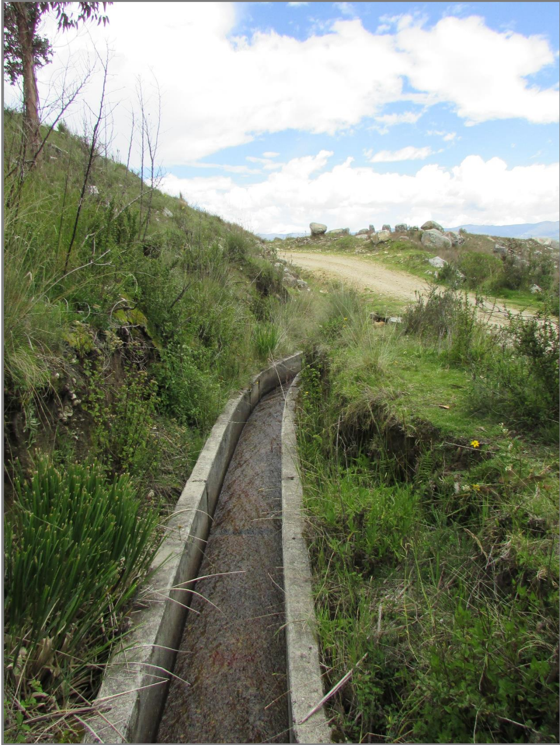
Fotografía 4. Tramo final del canal progresiva 1+000, junto a la carretera
