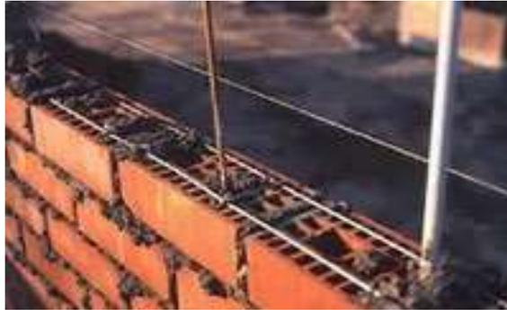
**Figura 9:** Muro de Albañilería Armada.
