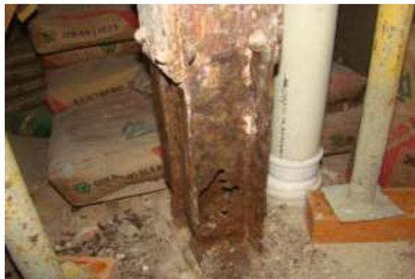
**Figura 28:** Patología Corrosión presente en una Columna.
