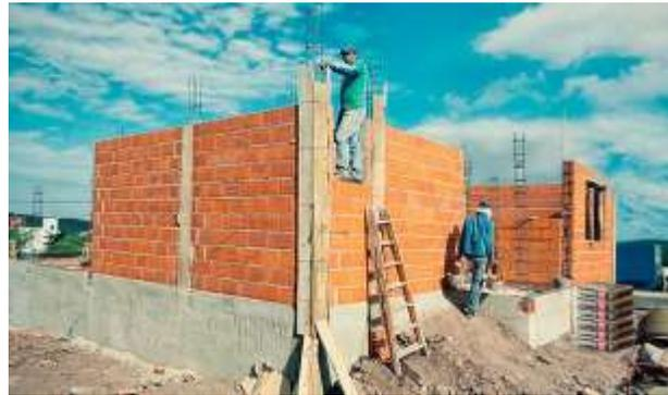
**Figura 8:** Vivienda con albañilería confinada.
