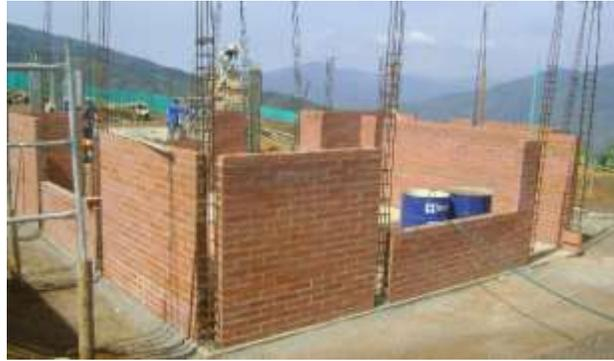
**Figura 18:** Muros de Albañilería.
