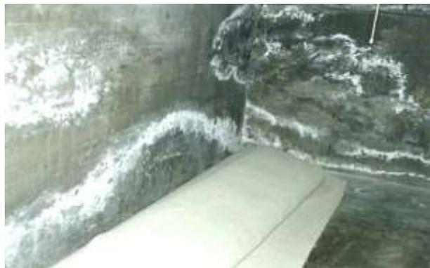
**Figura 29:** Patología Eflorescencia presente en los Muros.
