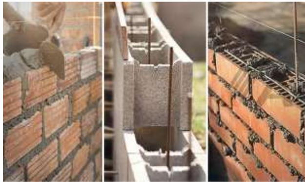
*Figura 7:* Muros de Albañilería.
