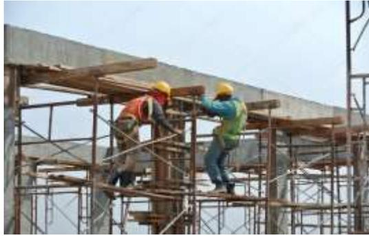
**Figura 15:** Desencofrado de una Viga de Concreto Armado.
