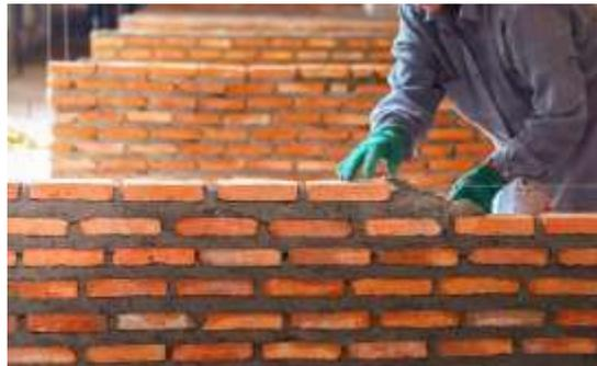
**Figura 10:** Construcción de Muro de Albañilería Simple.
