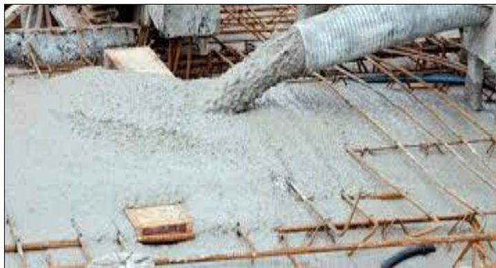
*Gráfico 11.* Imagen donde se aprecia el concreto armado.
