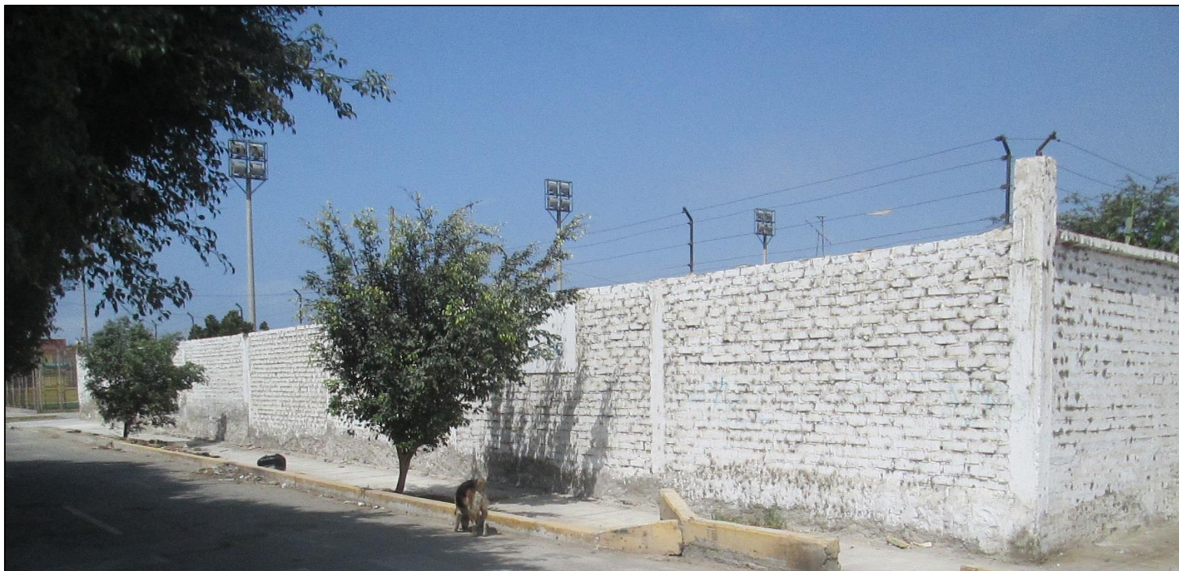
Fotografía 04. Vista posterior del exterior del cerco perimétrico ex centro médico especializado Santa Clara, Asentamiento Humano Antenor Orrego, distrito de Chimbote, provincia del Santa, región Áncash.
