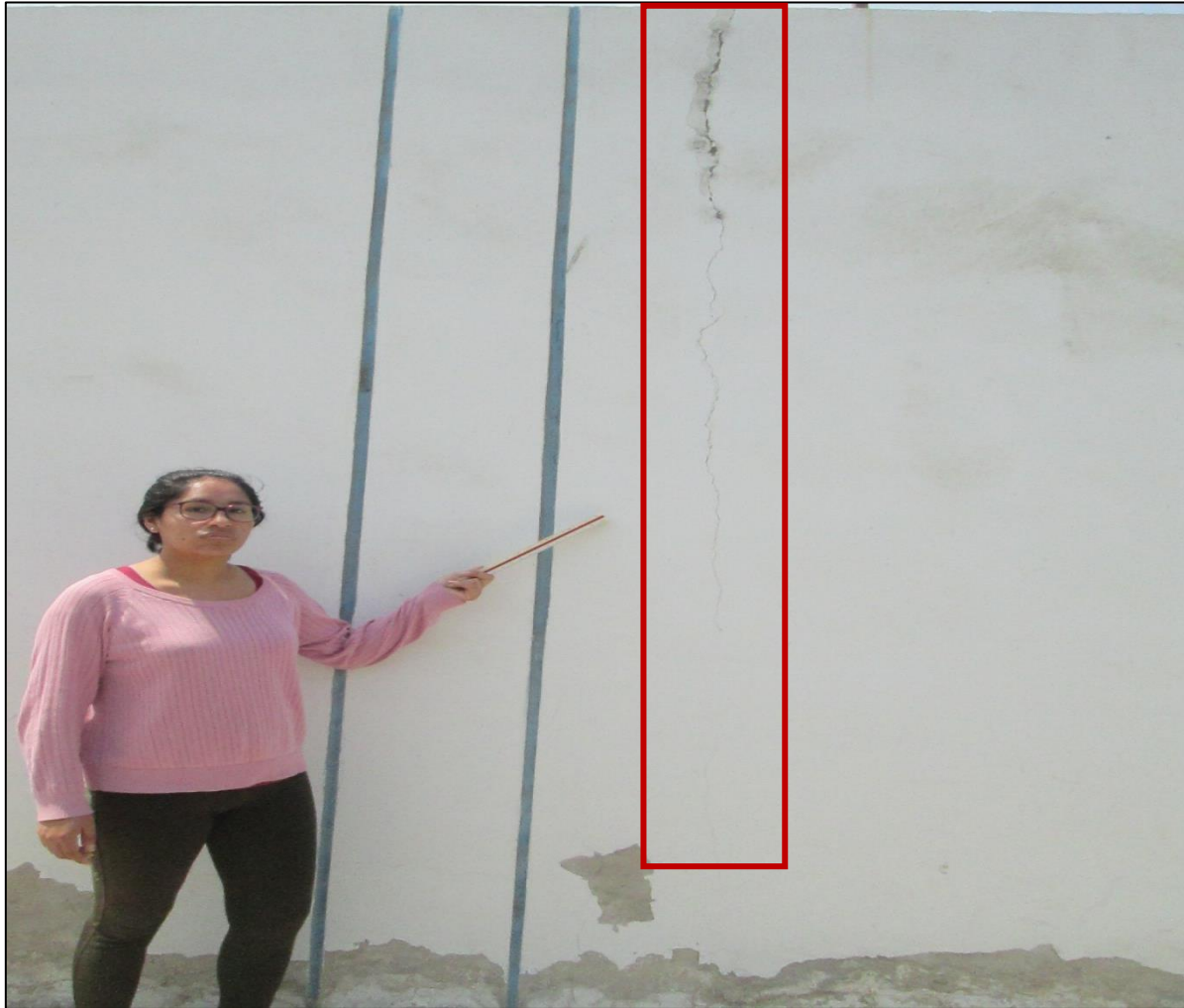
Fotografía 08. Muro afectado por fisura en la unidad muestral 02.
