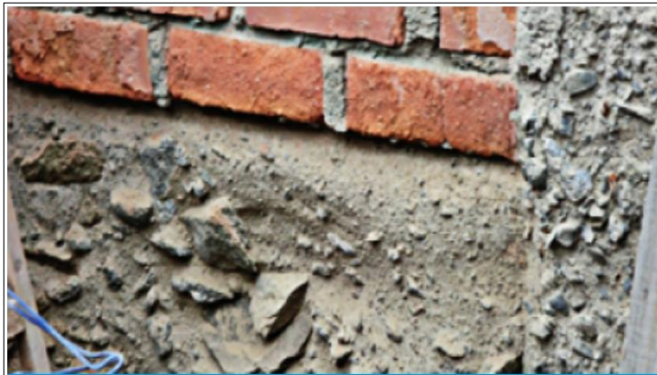
Gráfico 11. Imagen de desintegración del concreto por de sulfatos.
