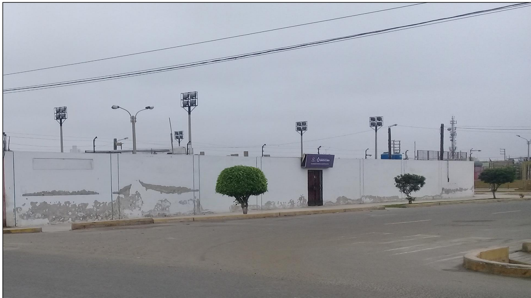
Fotografía 02. Vista frontal del exterior del cerco perimétrico ex centro médico especializado Santa Clara, Asentamiento Humano Antenor Orrego, distrito de Chimbote, provincia del Santa, región Áncash.
