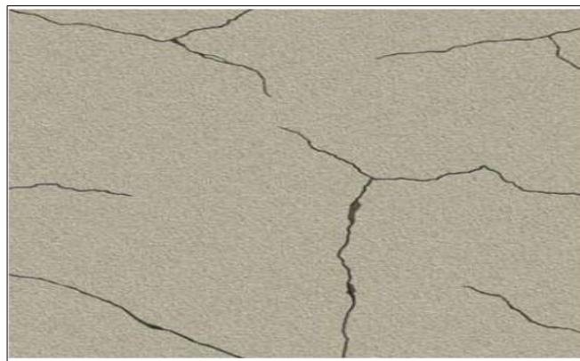
Gráfico 13. Imagen de fisura superficial en concreto
