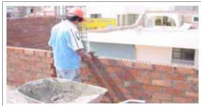
Gráfico 9: Imagen de construcción de muro
