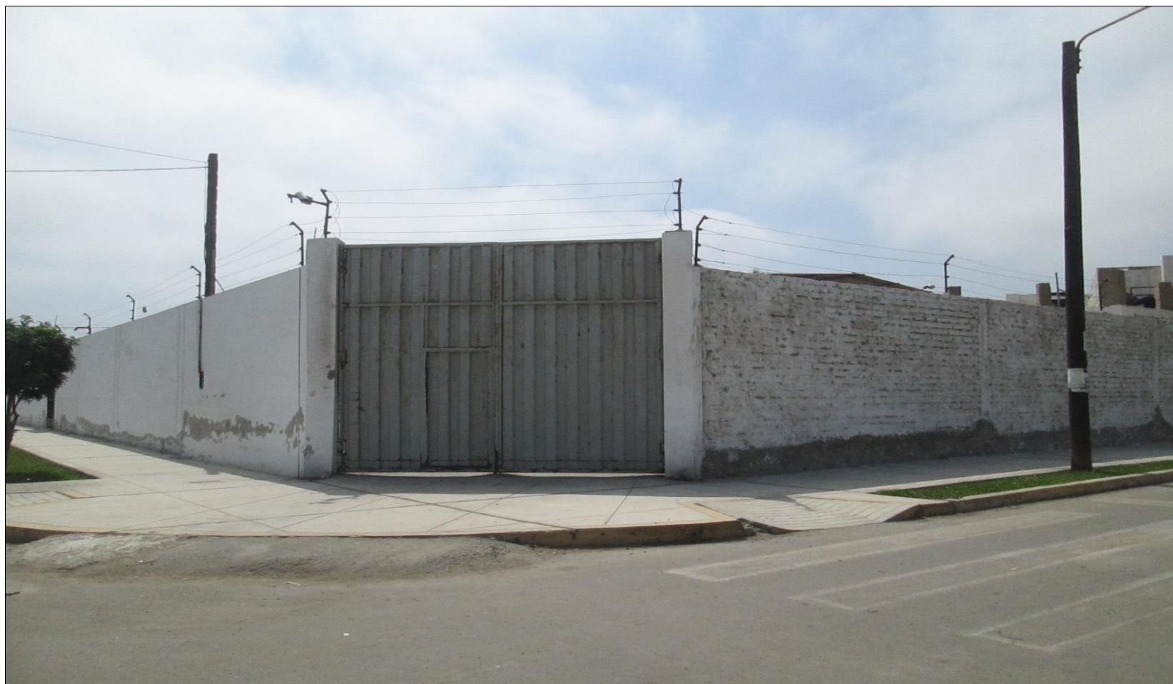
Fotografía 01. Vista panorámica del exterior del cerco perimétrico ex centro médico especializado Santa Clara, Asentamiento Humano Antenor Orrego, distrito de Chimbote, provincia del Santa, región Áncash.
