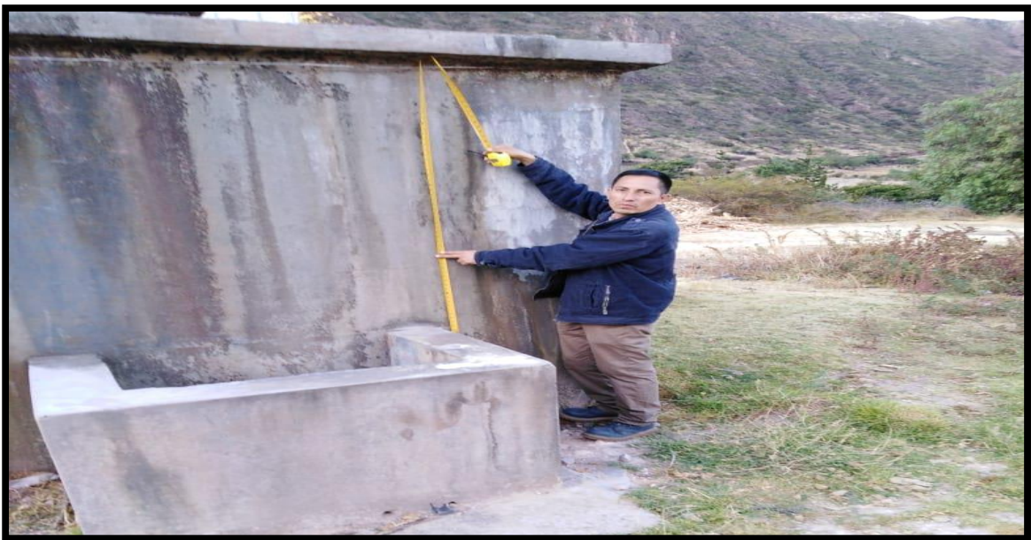
Foto 04: Vista lateral de la cámara de cloración.
