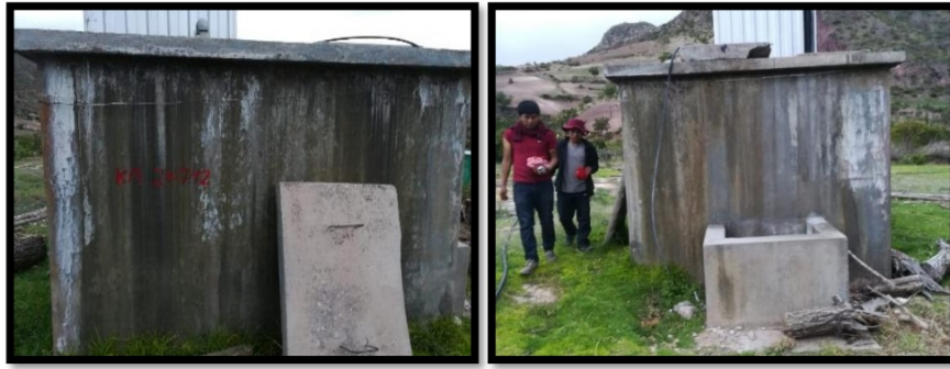
Figura 4.3: Reservorio Pamparque 5m 3 .
