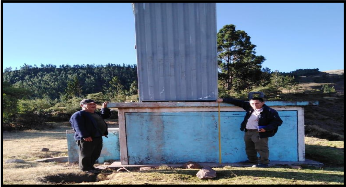
Foto 01: Vista frontal del Reservorio.
