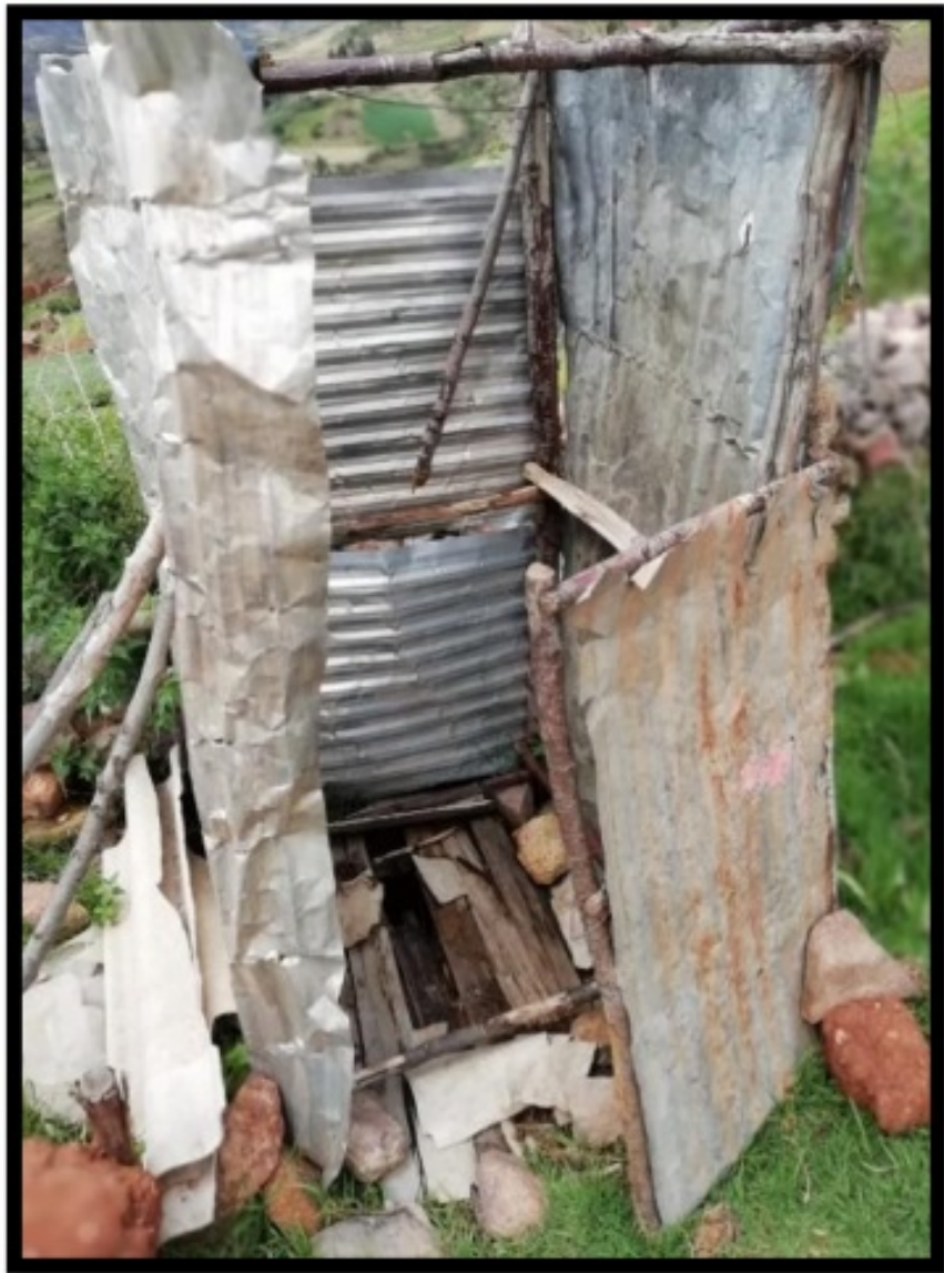
Figura 4.18: Disposición de excretas en pozo solo.
