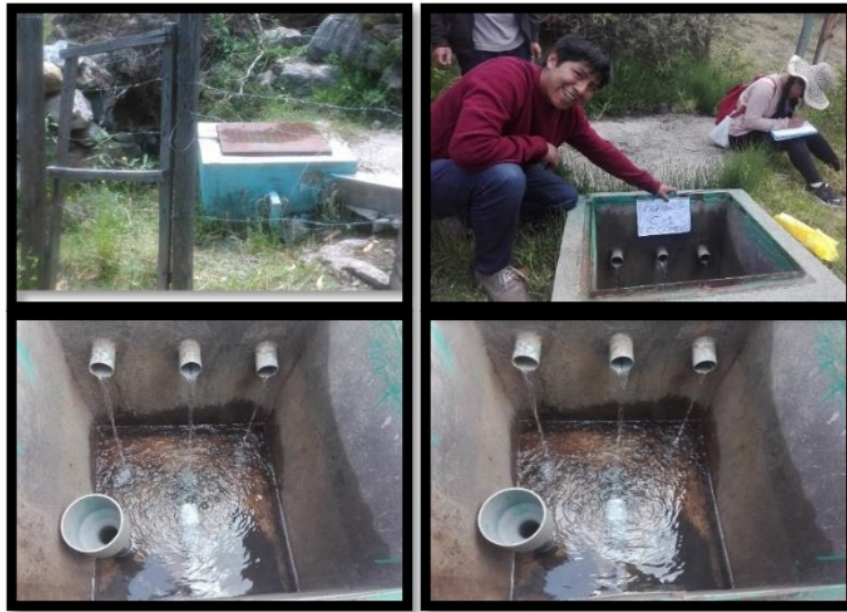
Figura 4.12: Captación tipo ladera.
