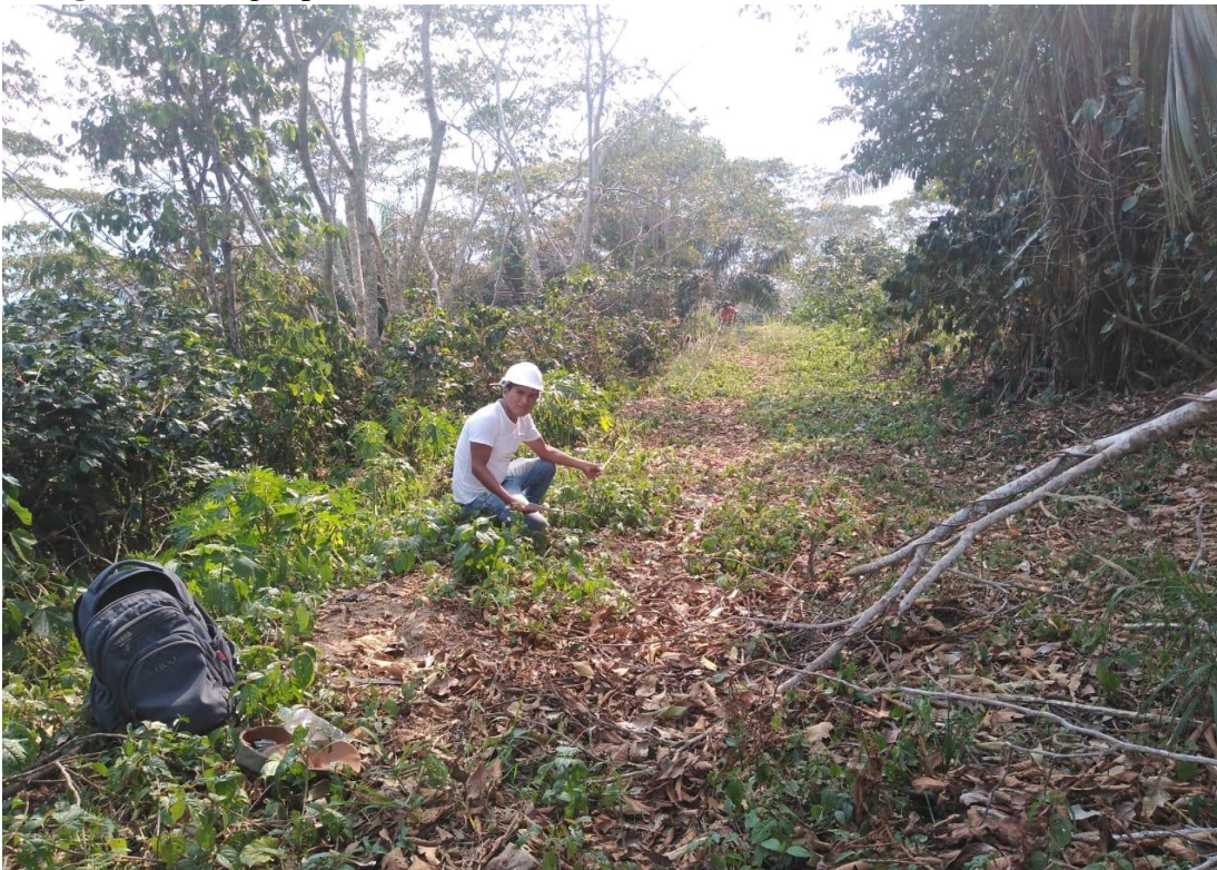
Fotografía 2. Lugar por dónde va colocar la línea de conducción.
