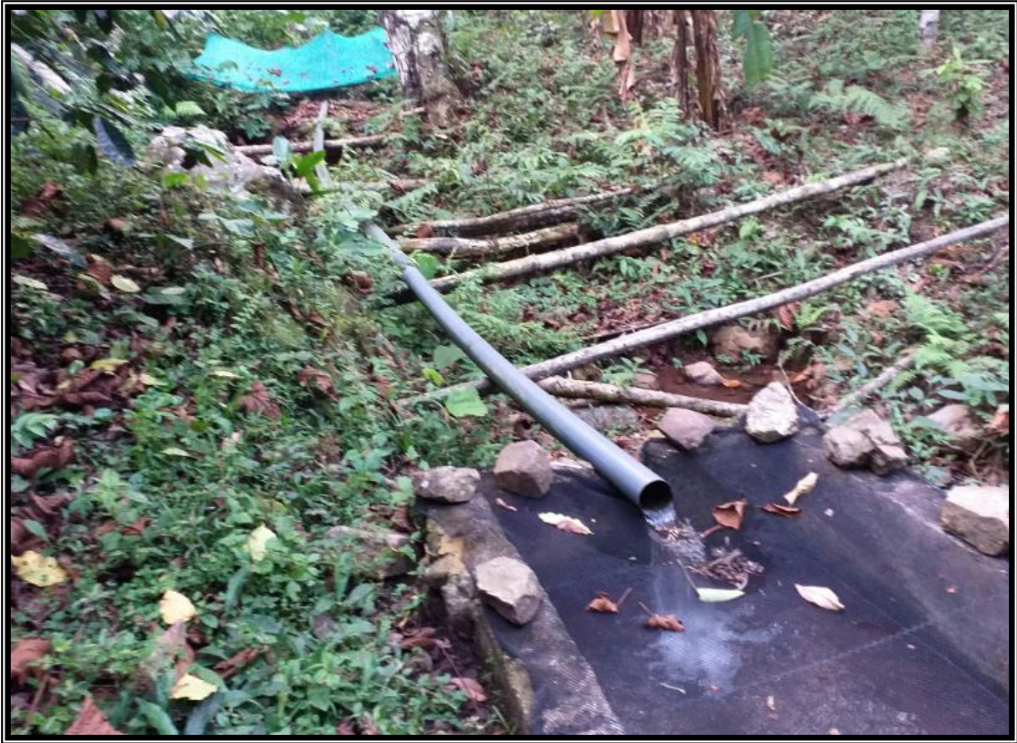
Figura 29. Estado actual de la captación artesanal del centro poblado Centro Huachiriki
