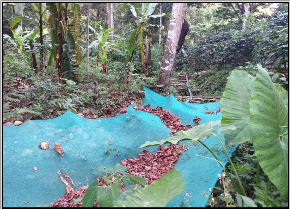
Figura 28. Estado actual de la captación artesanal del centro poblado Centro Huachiriki
