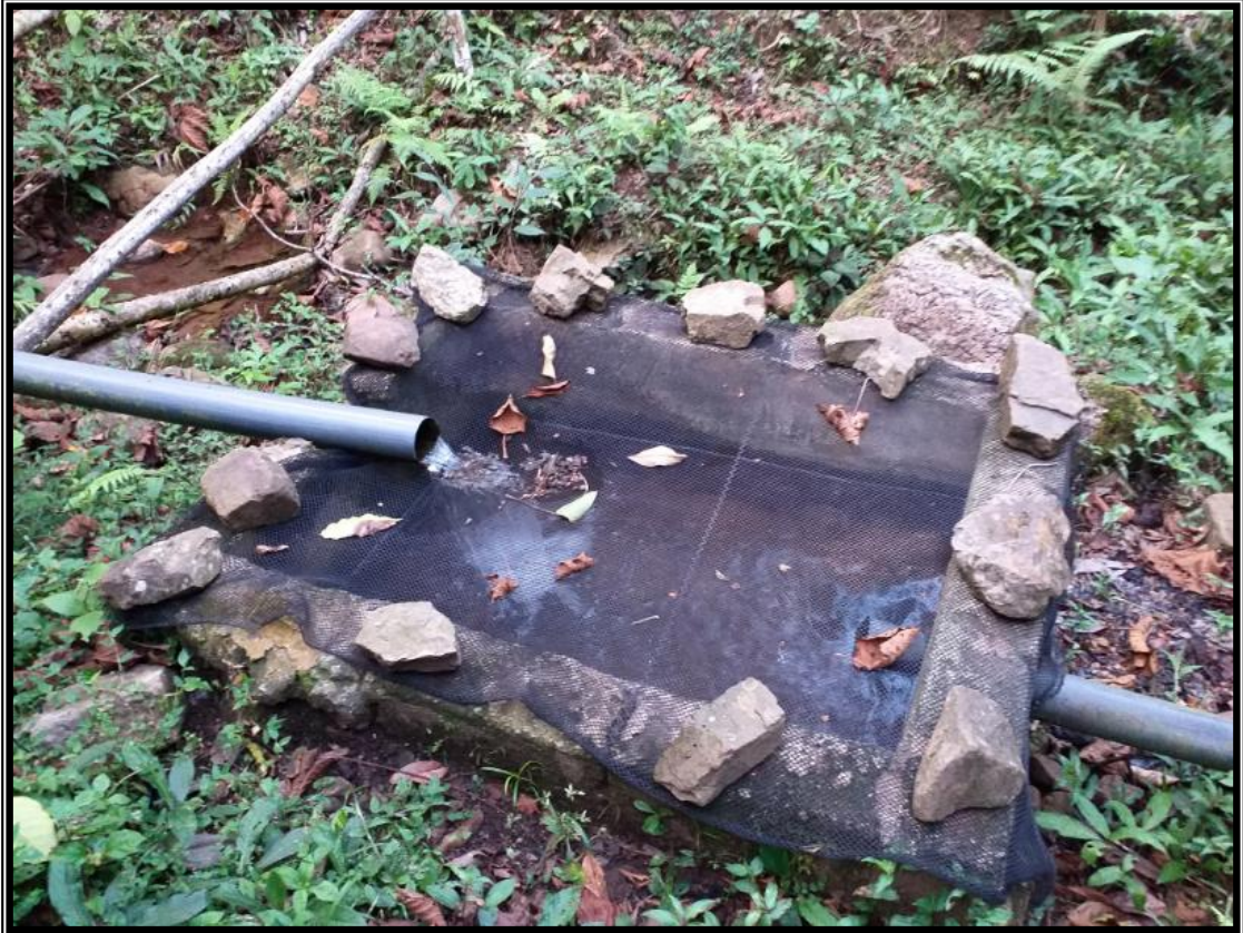
Figura 30. Estado actual de la captación artesanal del centro poblado Centro Huachiriki
