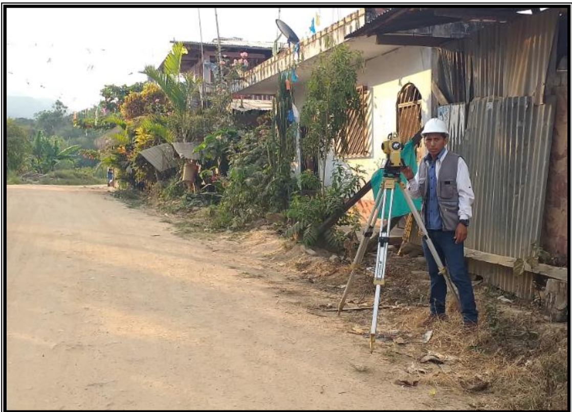
Figura 42. Se muestra realizando el levantamiento topográfico en el centro poblado Centro Huachiriki.
