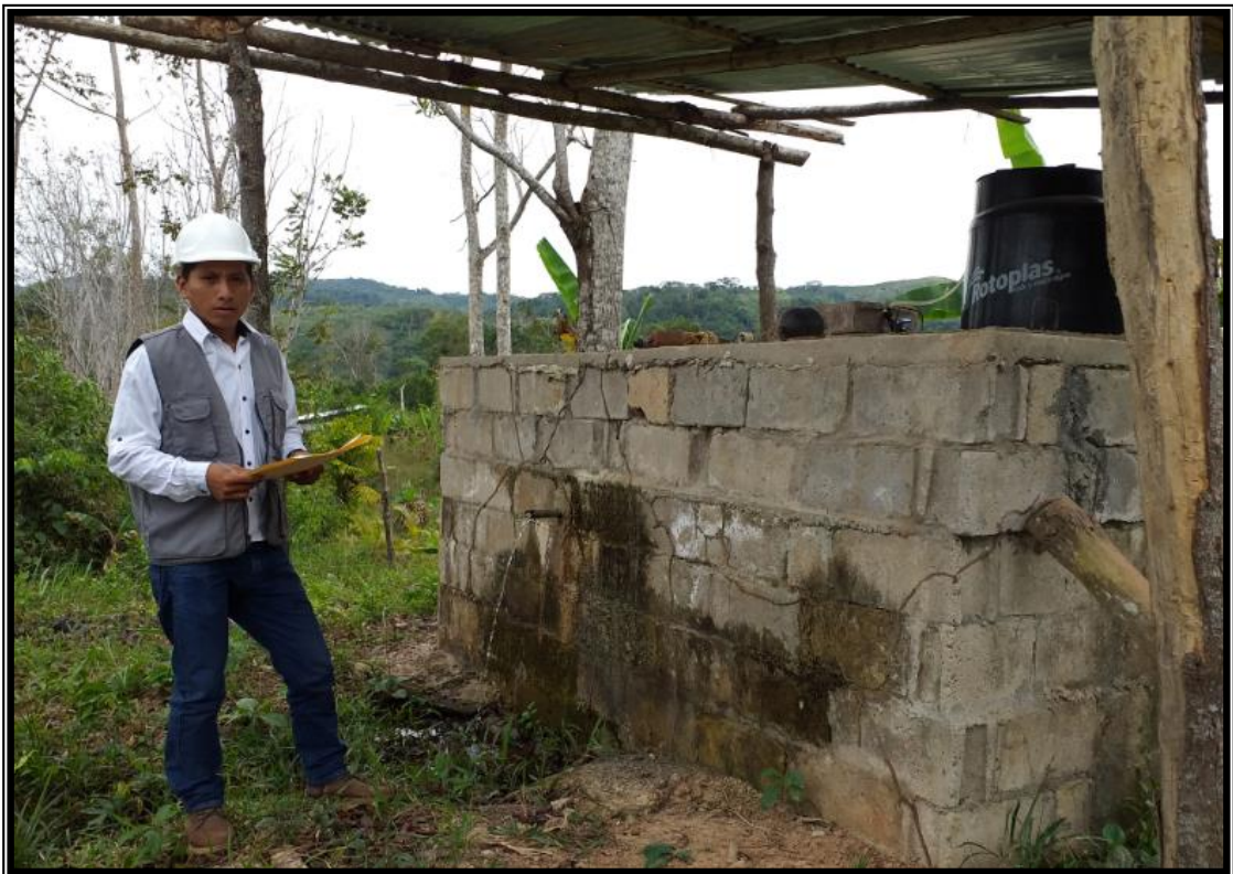
Figura 34. Se muestra realizando la verificación técnica de los elementos y estructuras hidráulicas a través de la ficha técnica de evaluación.
