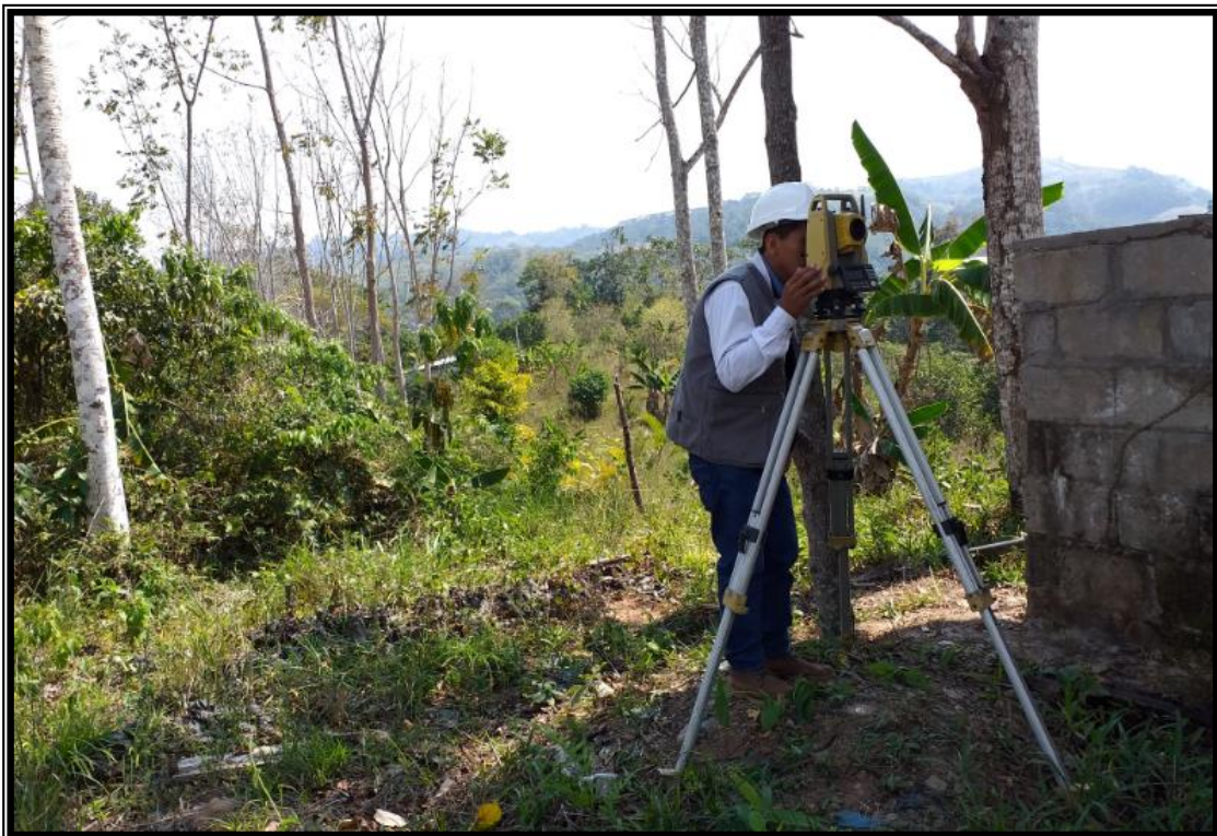
Figura 40. Se muestra realizando el levantamiento topográfico de la línea de aducción
