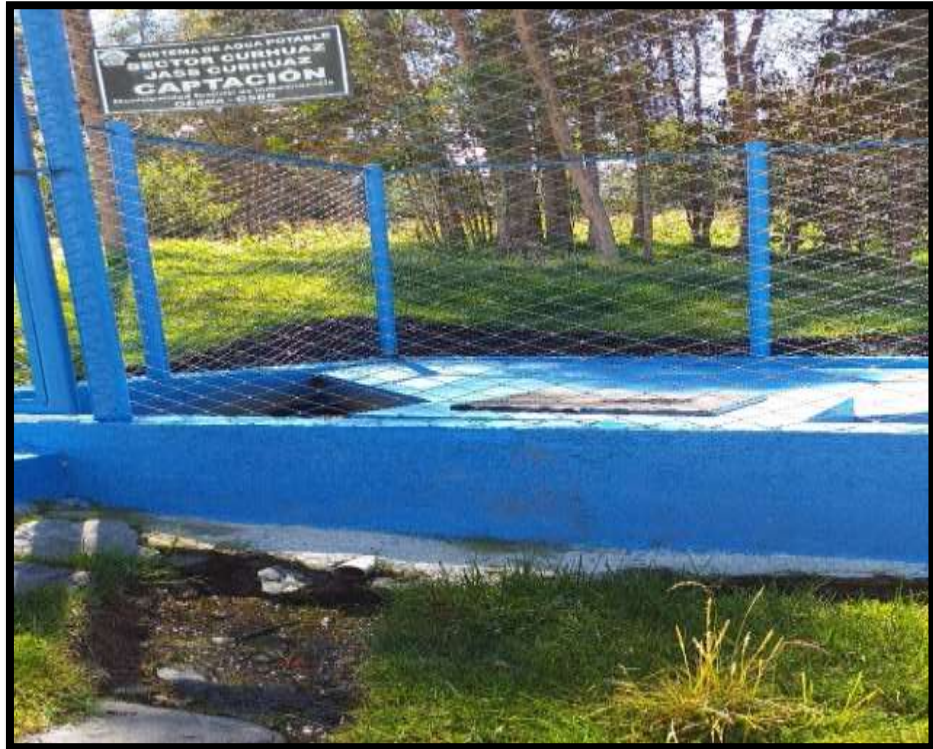
Fotografía N° 04: Captación N° 2, Observamos que cuenta con cerco perimétrico, no cuenta con la limpieza adecuada.
