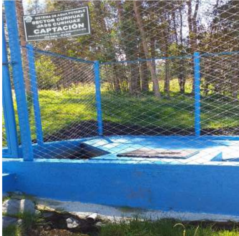
Fotografía N° 04: Captación N° 03 tipo Ladera, en el caserío de Curhuaz, buen estado de conservación, posee cerco perimétrico.
