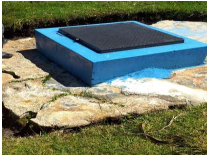
Fotografía N° 01: Captación N° 01 tipo Ladera, buen estado de conservación, no posee cerco perimétrico.
