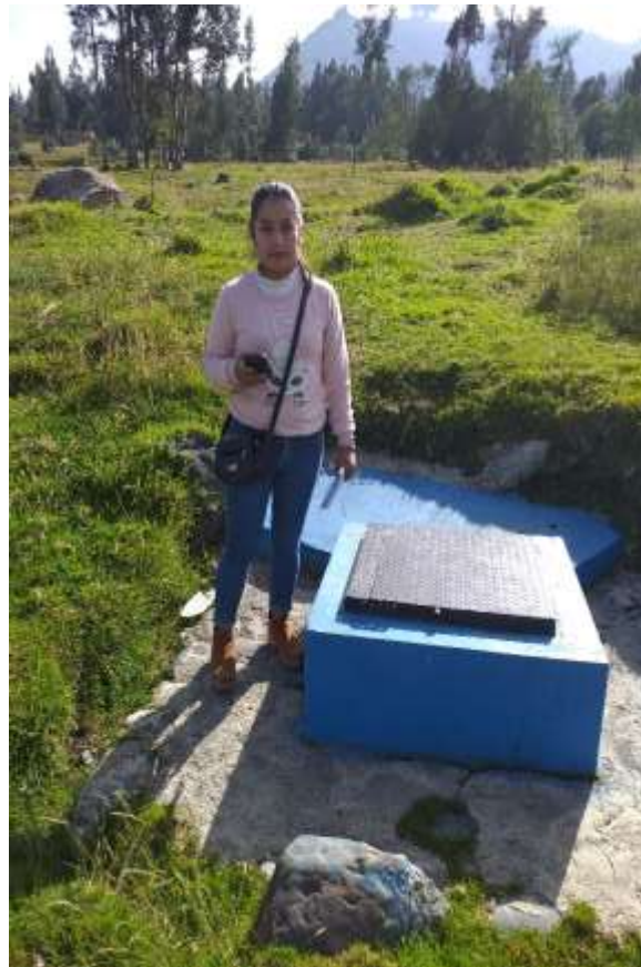
Fotografía N° 03: Captación N° 02 tipo Ladera, en el caserío de Curhuaz, buen estado de conservación, no posee cerco perimétrico.
