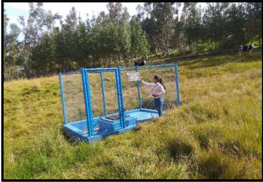
Fotografía N° 06: Captación N° 4, 5 y 6, Observamos que cuenta con cerco perimétrico, las demás captaciones no cuentan con ello.
