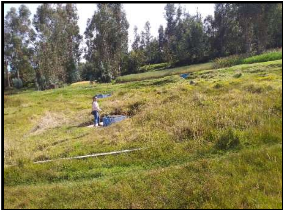
Fotografía N° 07: Captación N° 4, 5 y 6, Observamos que cuenta con cerco perimétrico, las demás captaciones no cuentan con ello.
