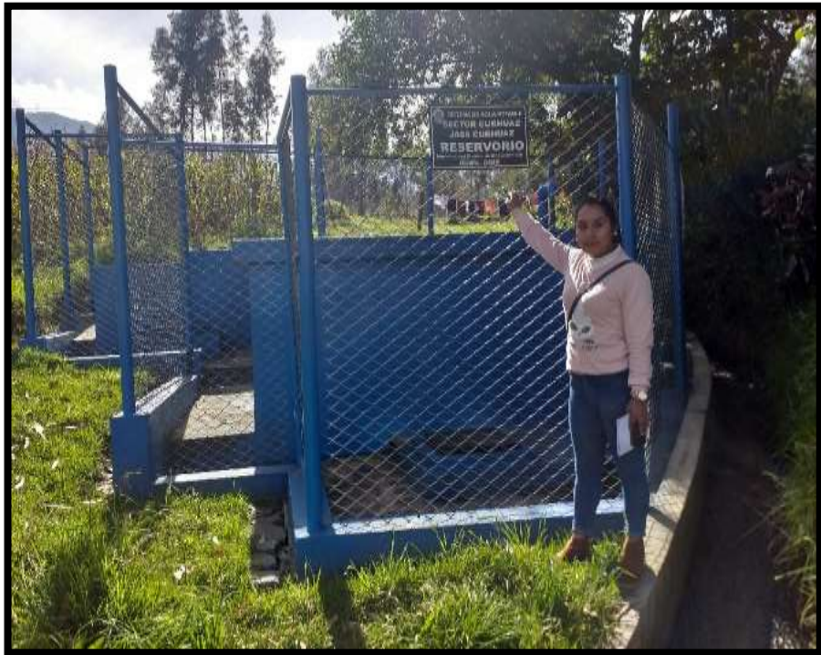
Fotografía N° 09: Reservorio N° 2, Reservorios se encuentran con cerco perimétrico y en buen estado.
