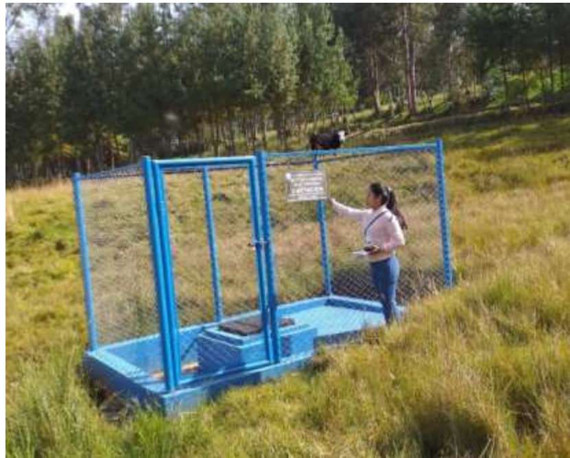
Fotografía N° 05: Captación N° 04 tipo Ladera, en el caserío de Curhuaz, buen estado de conservación, posee cerco perimétrico.
