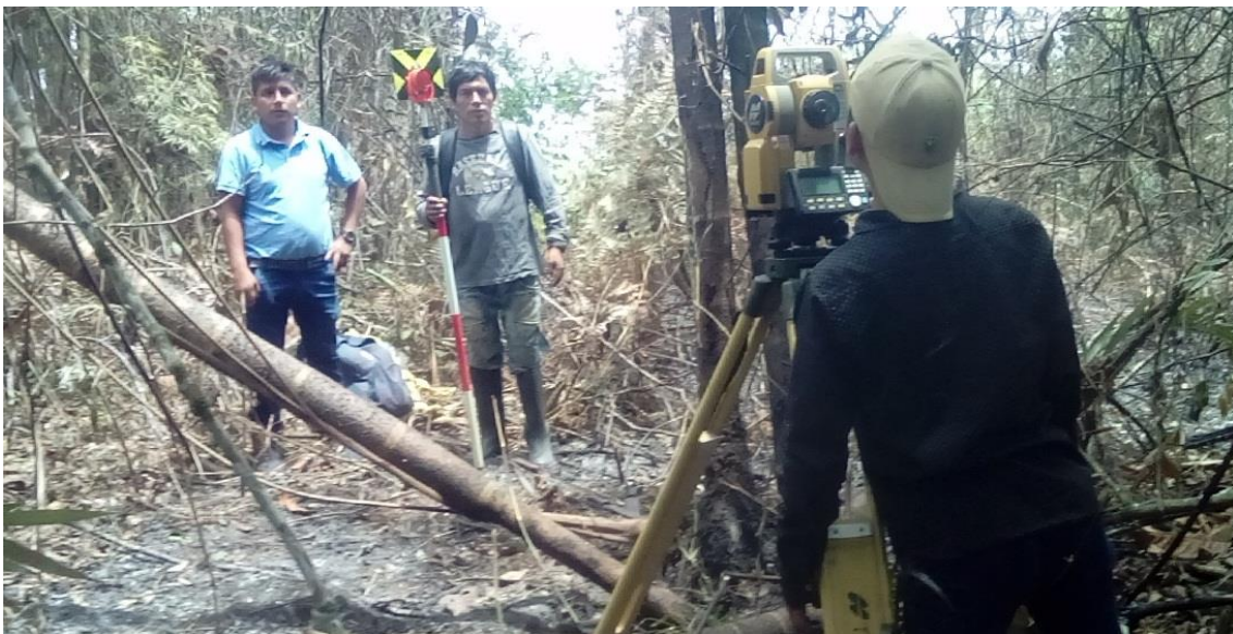
Fotografía N° 04: Vista del km 0+996 donde se propone el reservorio apoyado con capacidad de 10m 3 .
