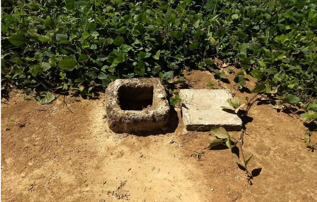
**Imagen N° 05.** Se observa las cajas de registro de agua en malas Condiciones
