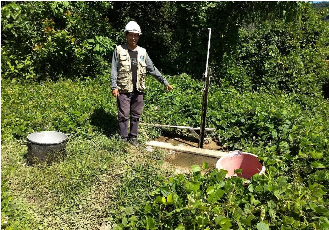
**Imagen N° 06.** Se observa las conexiones domiciliarias en mal estado
