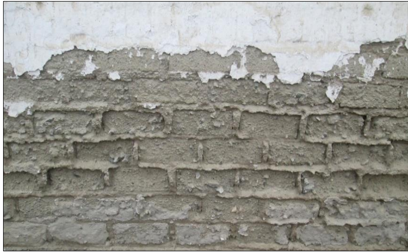
Gráfico 12 . Imagen de presencia de erosión en el muro Nota. Fuente: Elaboración Propia (2019).
