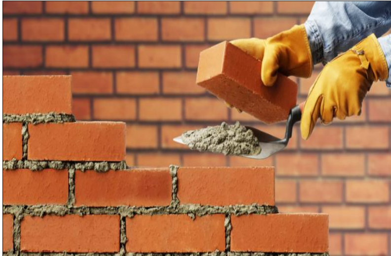
Gráfico 10. Imagen de detalle del uso del mortero en el asentado del ladrillo
