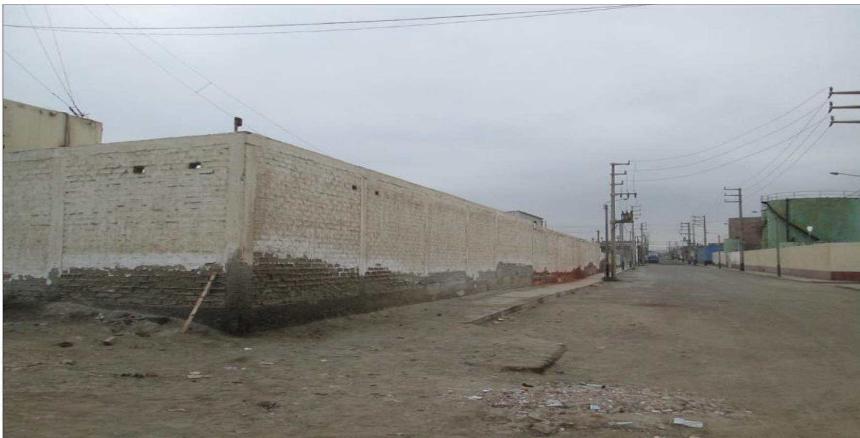
Fotografía 03. Vista del tramo B – A del cerco de la ex empresa pesquera Imbesmeh, ubicado en pueblo joven Florida baja en el distrito de Chimbote, provincia del Santa, región Áncash.
