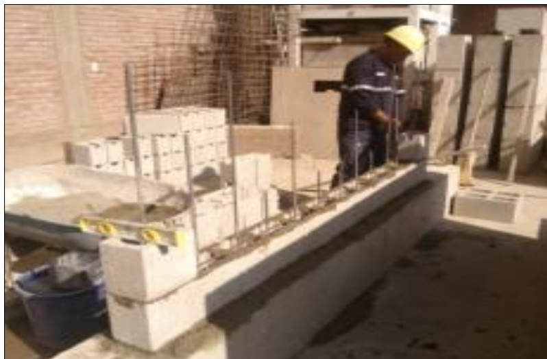
Gráfico 5. Imagen de albañilería armada. Nota. Fuente: Chávez, O, Seminario F. (2014)
