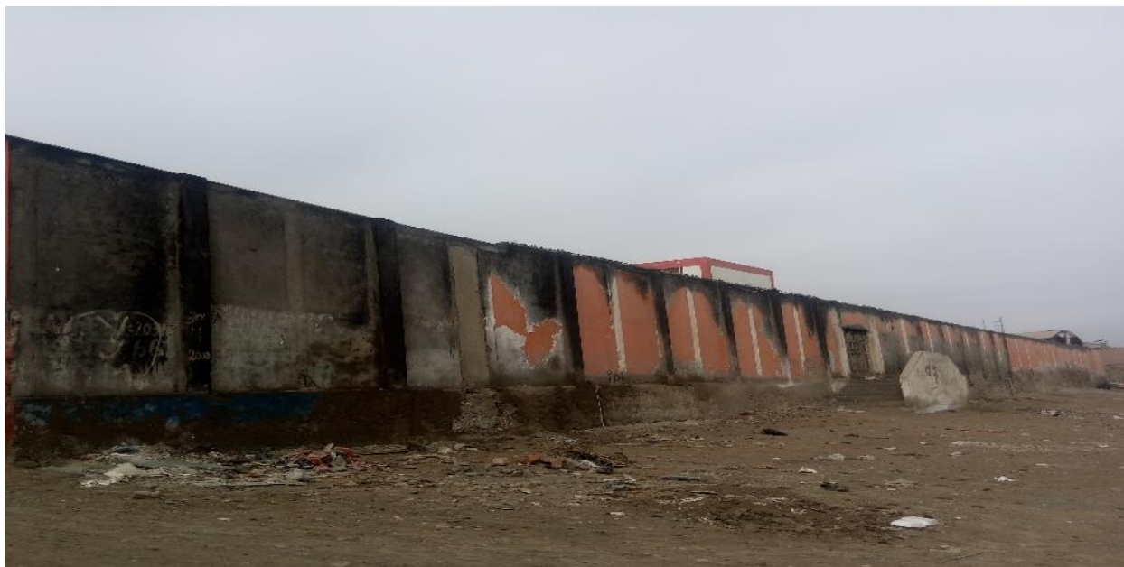
Imagen de la vista posterior del cerco perimétrico de la institución educativa 20313 virgen de la merced
