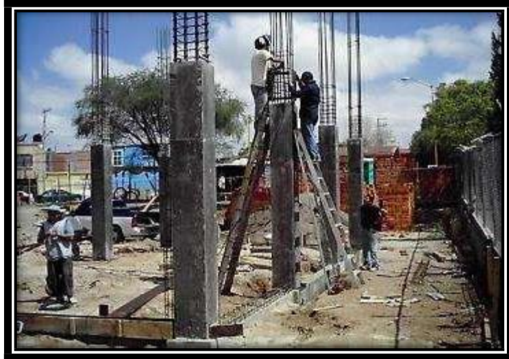
Gráfico 7. Columna de concreto armado, Trujillo
