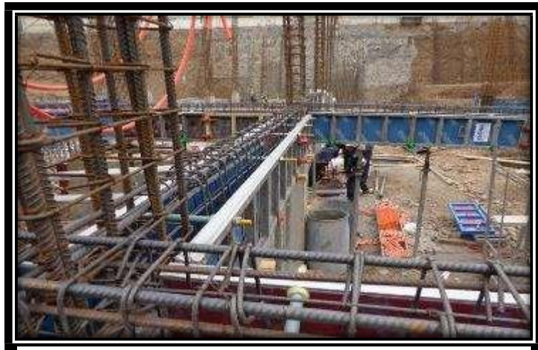
Gráfico 8. Encofrado metálico de una viga peraltada, Cartagena- Colombia Fuente: DOM (2014)
