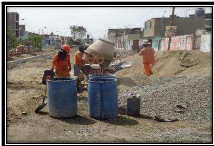
Gráfico 12. Componentes y preparación de concreto
