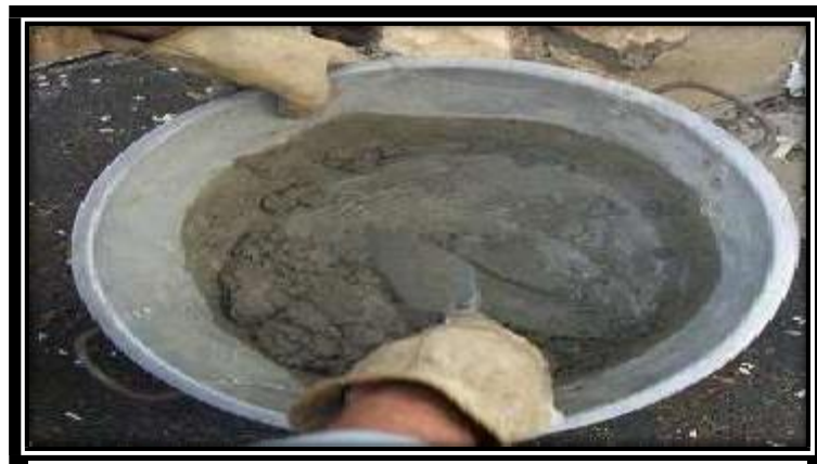
Gráfico 10.Preparación de mortero Fuente: Chema (2016)
