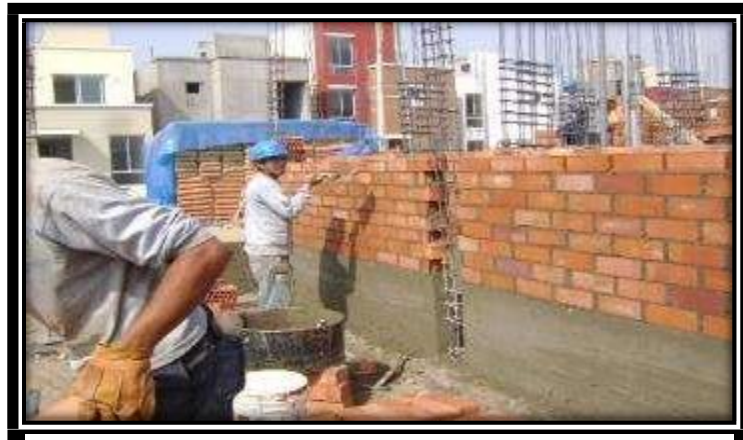
Gráfico 4. Construcción de una vivienda de albañilería Fuente: ICIC (2018).
