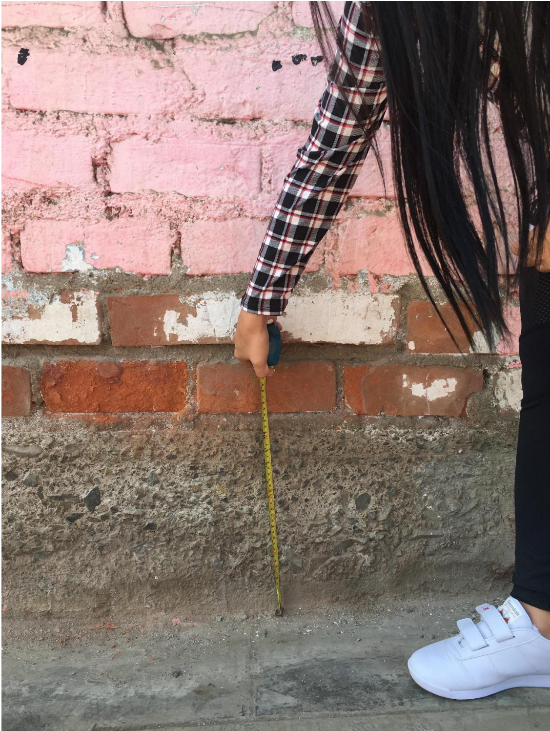
Figura 20: Medida del ancho de la patología erosión física de la unidad de muestra N° 05 para ser vaciada a la hoja de datos de nuestra ficha de evaluación.
