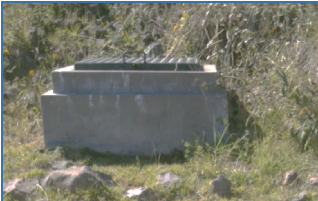
Imagen 8: Cámara de rompe presión tipo-6 de agua potable de la comunidad de San Martín de Ccoriacc
