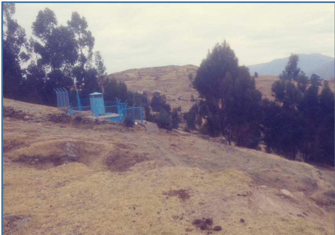
Imagen 9: Reservorio de agua potable de la comunidad de San Martín de Ccoriacc
