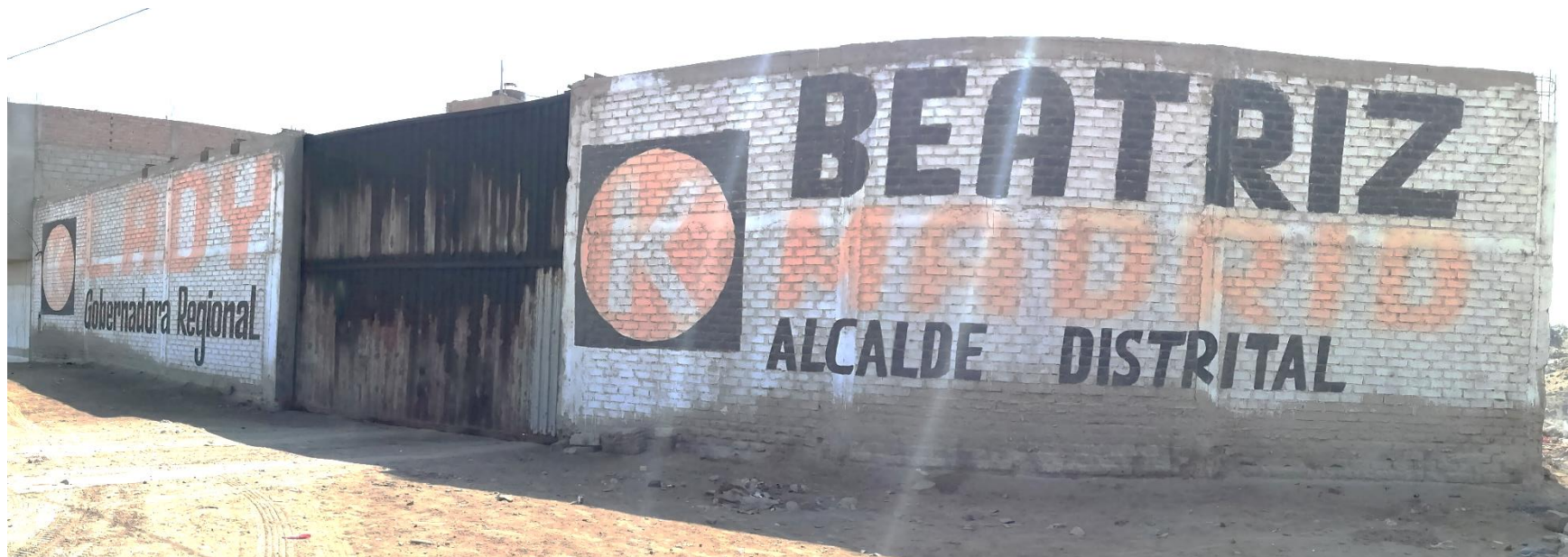
Fotografía 1. Vista Panorámica de la Fachada del Lote 5 Manzana A
