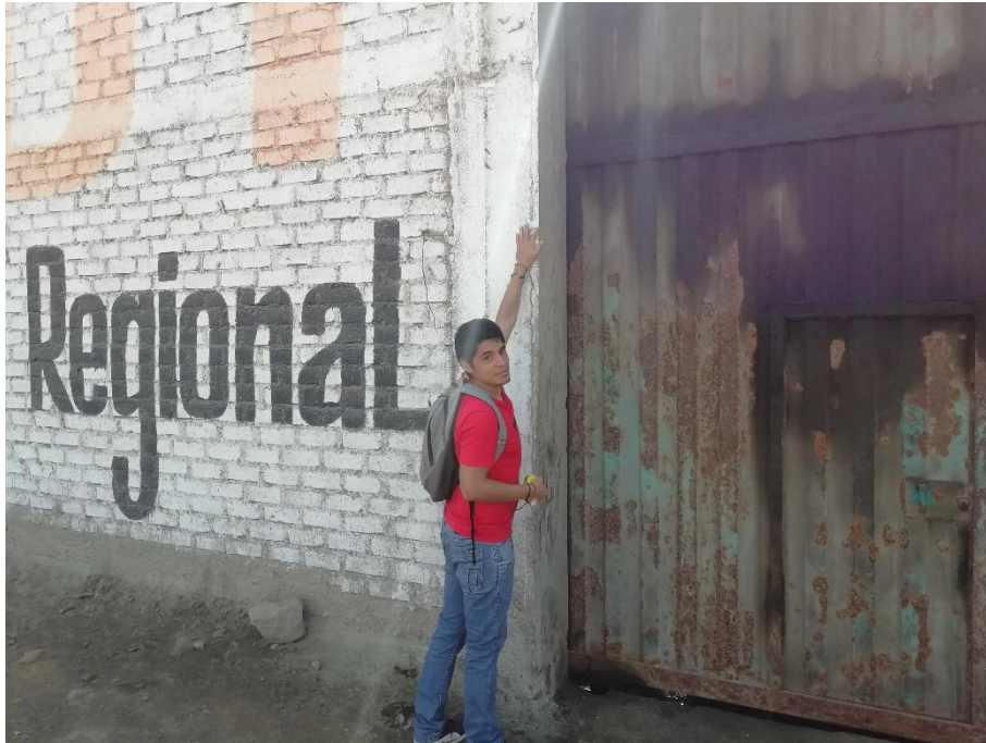
Fotografía 4. Columna afectada por fisura en muestra 3.
