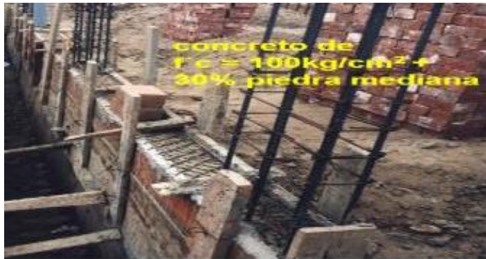
Figura 4: Detalle de Sobrecimiento.
