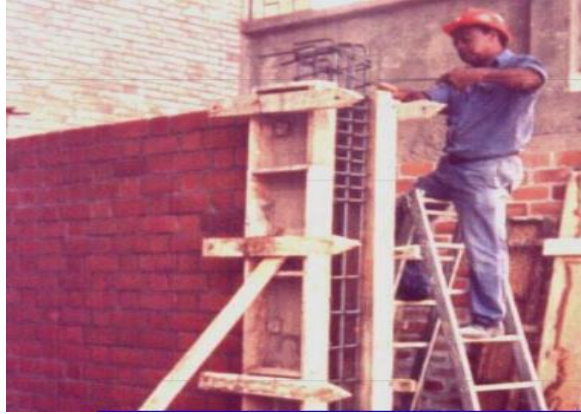
Figura 5: Encofrado de Columna.
