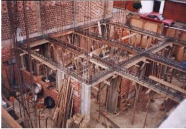
Figura 6: Construcción de Viga de Concreto Armado.
