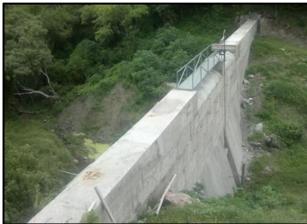
**Figura 18.** Presa de concreto ciclópeo - México.
