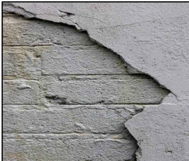
**Figura 23.** Desprendimiento del mortero - España.
