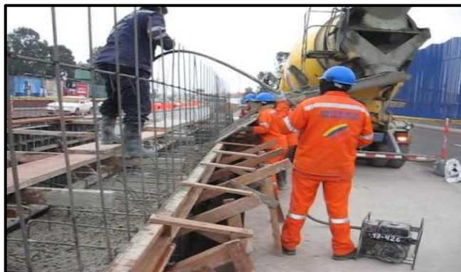
**Figura 10.** Llenado sobrecimiento estación Teran. Lima – Perú. Fuente: Cosac Sur (2009).
