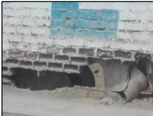
**Figura 24.** Desintegración de muro de albañilería.
