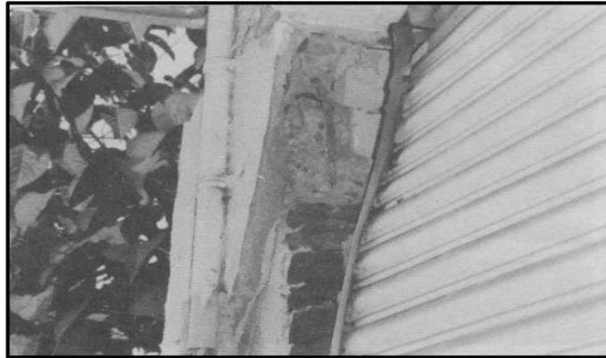
*Figura 1.* Agrietamiento inclinado y fractura de concreto de columna, Guayaquil-Ecuador.
