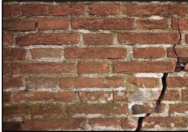
**Figura 22.** Presencia de grietas en muro.
