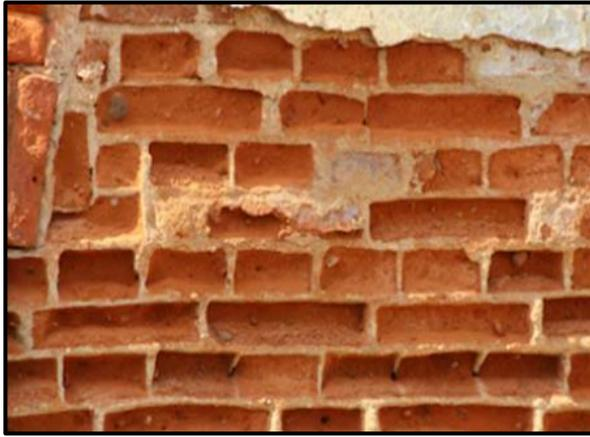
**Figura 20.** Erosión en pared de ladrillos.
