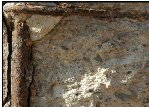
**Figura 25.** Corrosión en columna.
