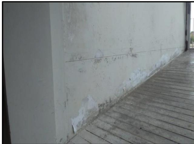
**Figura 26.** Presencia de eflorescencia. Piura - Perú.
