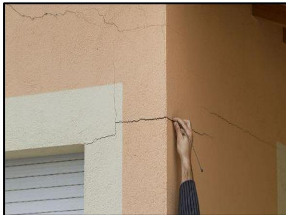
**Figura 21.** Fisura en muro de una vivienda. España. Fuente: El País (2015).
