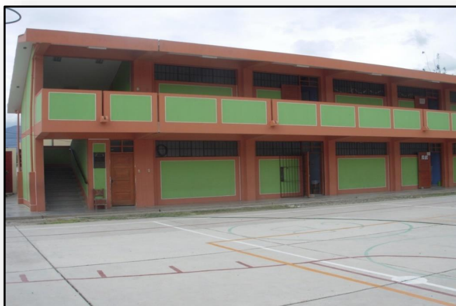
Vista interior de la Institución Educativa
