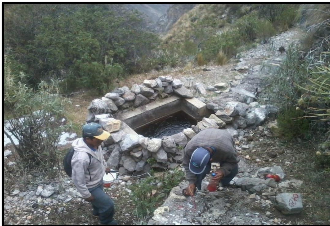
Fuente: Registro propio (insitu)
