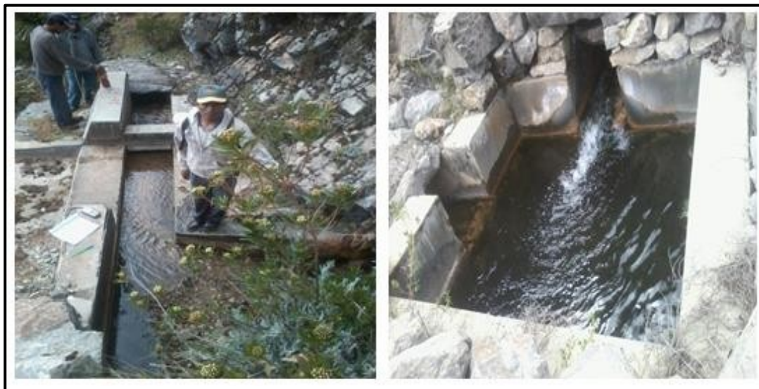
Fuente: Registro propio (Insitu)
