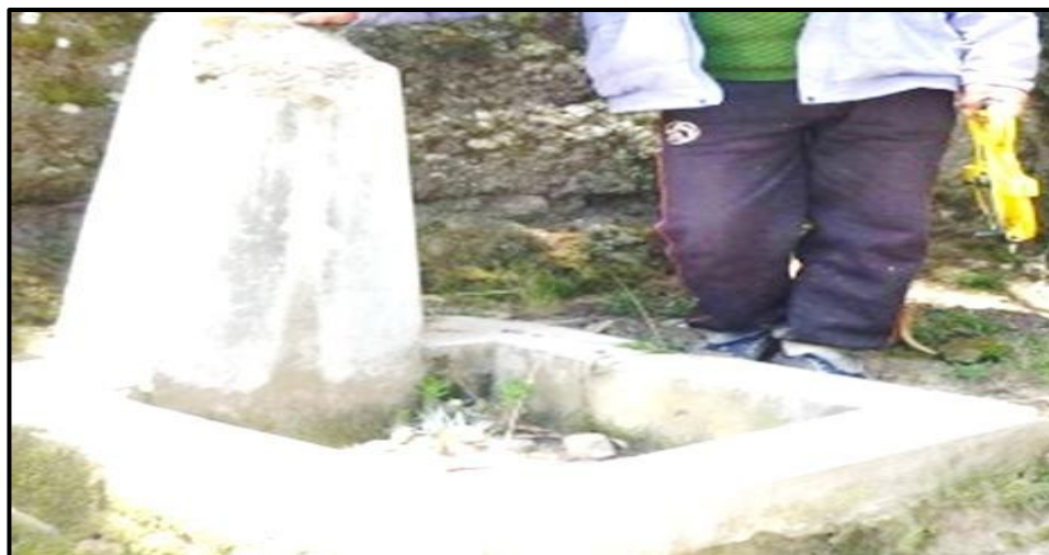
Fuente: Registro propio (Insitu)
