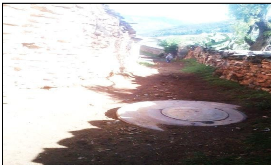
Fuente: Registro propio
