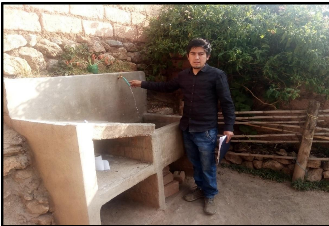
Fuente: Registro propio (Insitu)
