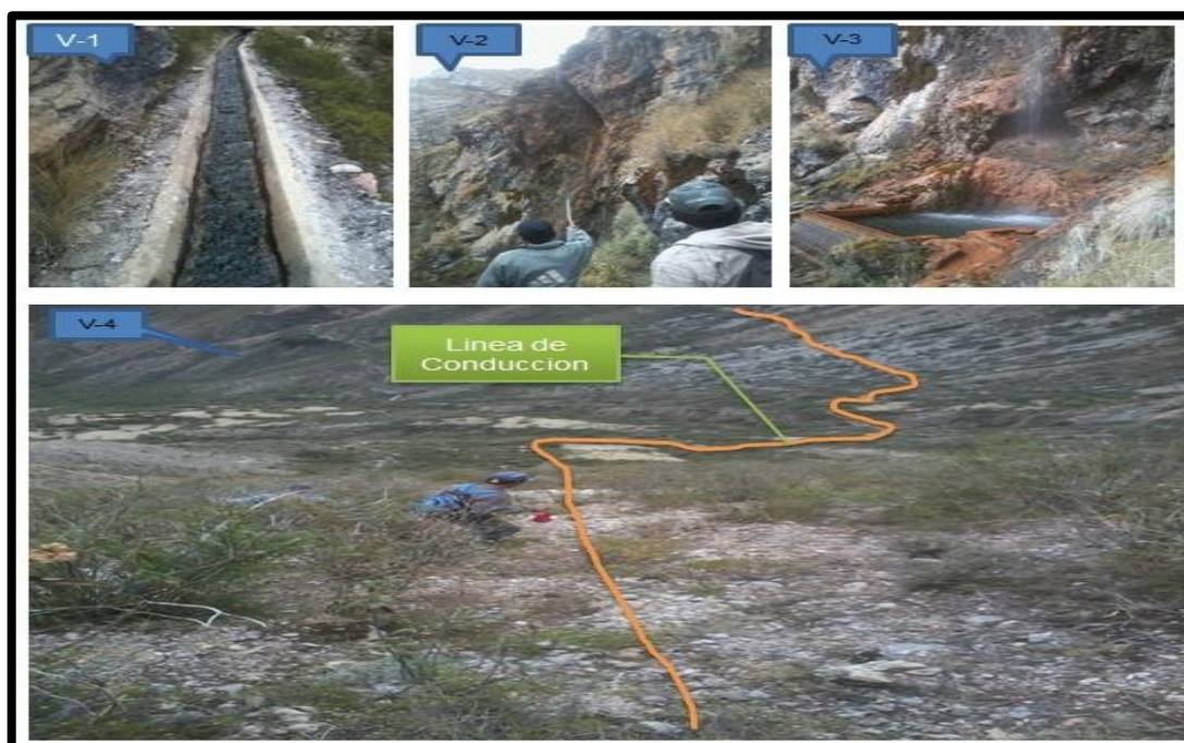
Fuente: Registro propio (Insitu)
