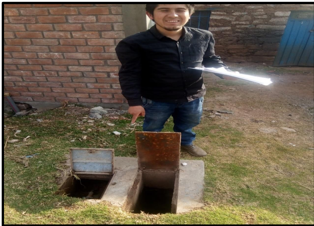
Fuente: Registro propio (Insitu)
